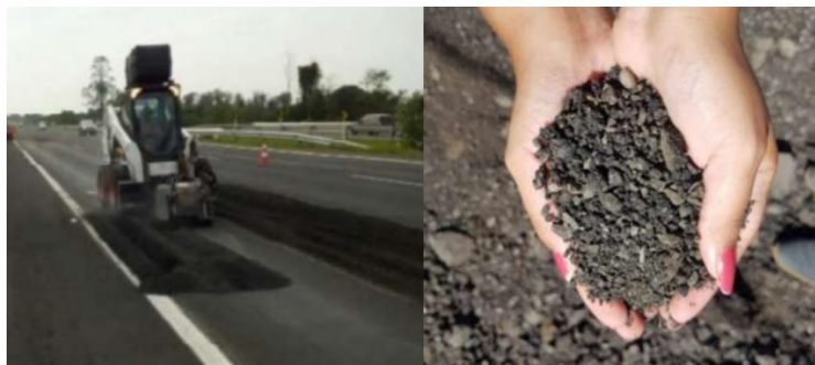
Figura 6 – Equipamento utilizado na fresagem e tambor de fresagem. Detalhe do RAP originário da fresagem do trecho BR-290/RS
