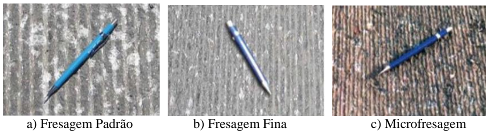
Figura 1 - Comparação entre os tipos de fresagem quanto à rugosidade resultante na pista
