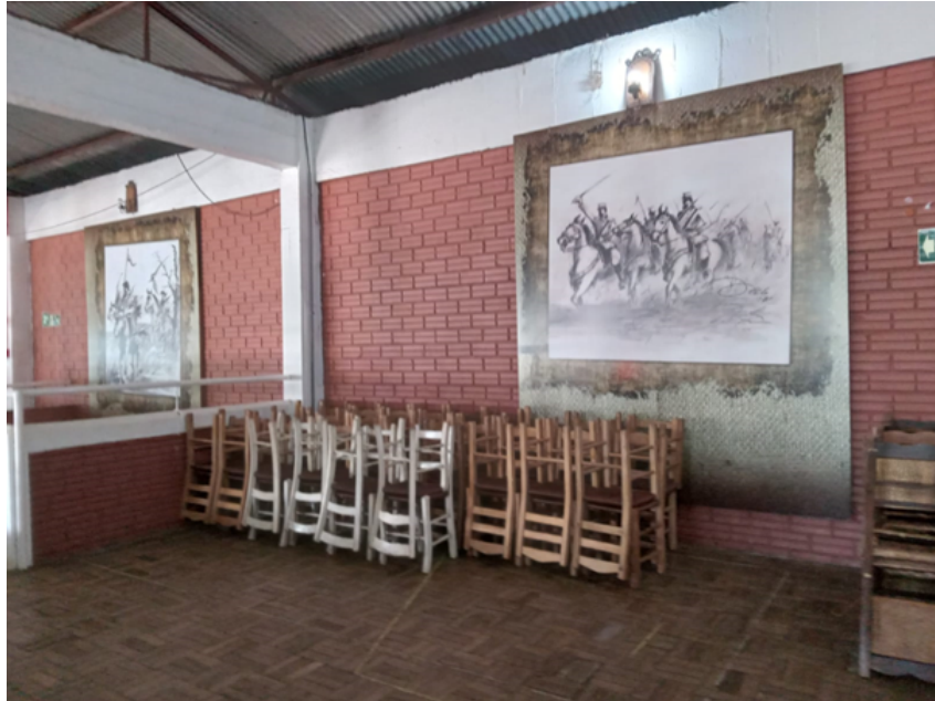
Figura 17 – Painéis com pinturas temáticas que encobriram as esquadrias.
