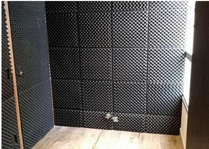
Figura 19 – Exemplo de parede revestida com espuma polimérica.
