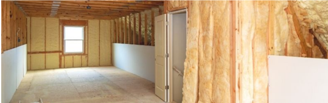
Figura 20 – Exemplo do uso de lã de vidro para isolamento acústico.
