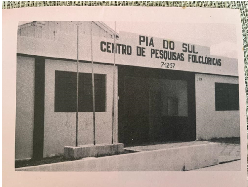
Figura 28 – Frente do CPF Piá do Sul com apenas um pavimento .
