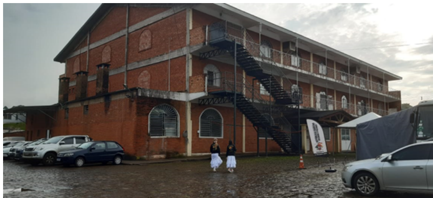
Figura 18 – Fachada e lateral do CTG com janelas cobertas por paredes de alvenaria.
