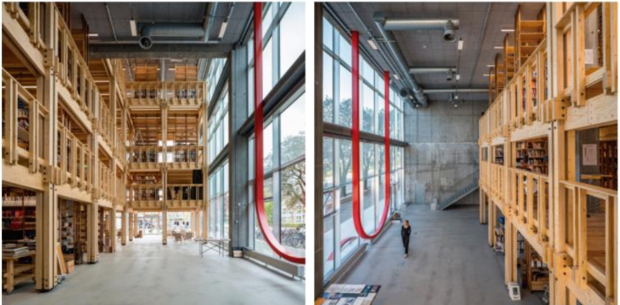
Figura 32 - Biblioteca com madeira recuperada de outra edificação.
