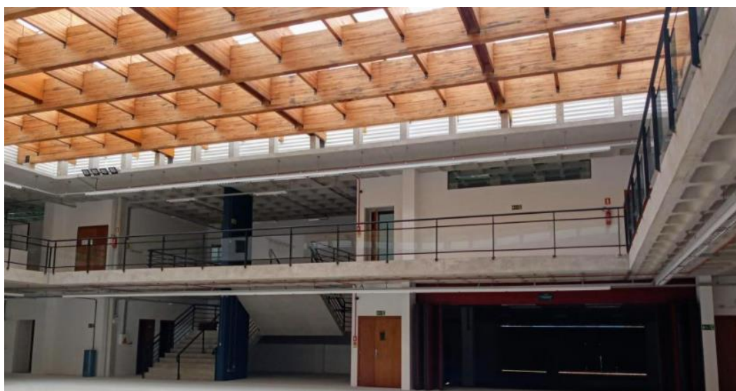
Figura 8- Interior do prédio do CAU-UFSM-SM.
