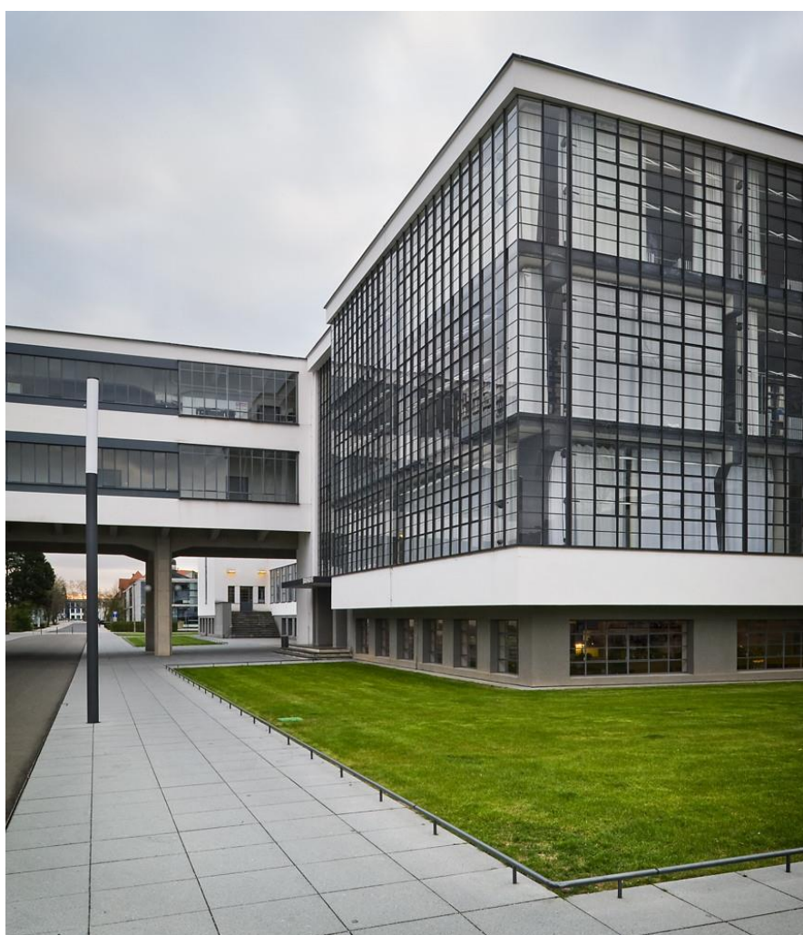
Figura 14 - Destaque para o setor administrativo sobre pilotis.
