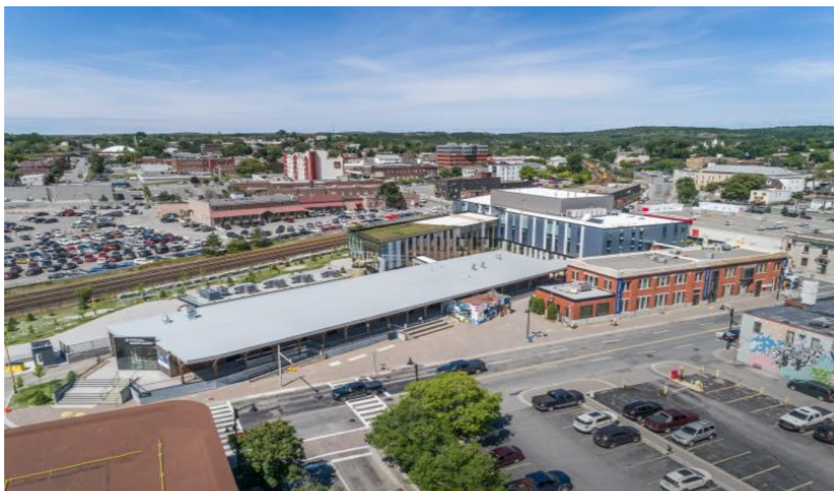
Figura 21 -Localização da Escola de Arquitetura McEwan, no cruzamento de uma rodovia com uma linha férrea.
