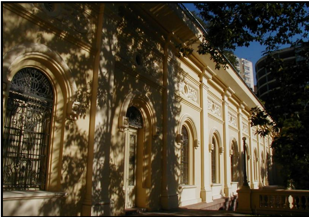
Figura 1 – Arquivo Público do Estado do Rio Grande do Sul – Fachada do Prédio I. Fonte: ARQUIVO PÚBLICO DO ESTADO DO RIO GRANDE DO SUL, [20--]. CD- ROM.
