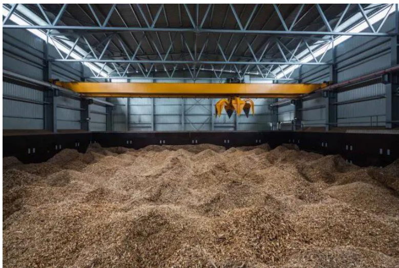
Figura 2.9 - Galpão de armazenamento de bagaço da cana-de-açúcar
