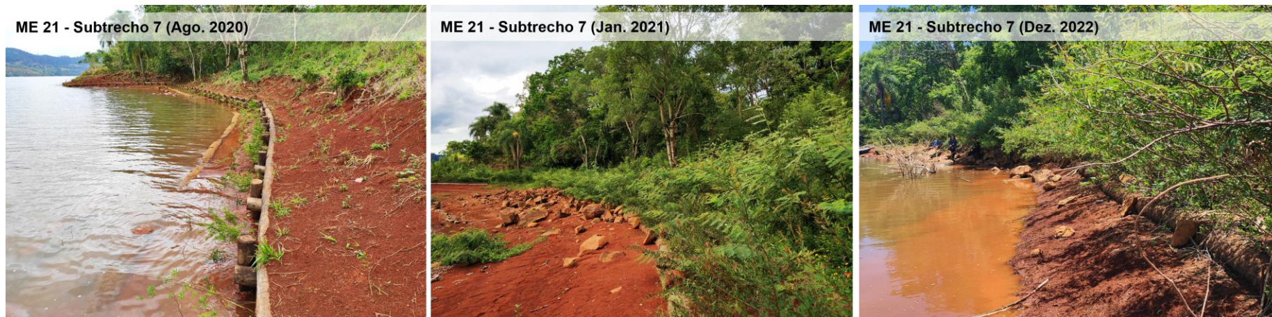
Figura 76 - Evolução das técnicas implantadas no trecho ME 21 (subtrecho 7) do reservatório da UHE Itá.
