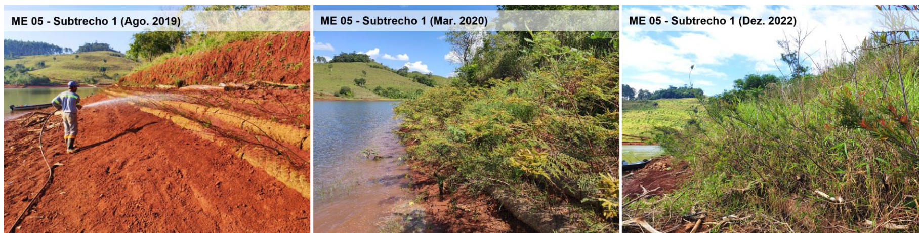
Figura 62 – Evolução das técnicas implantadas no trecho ME 05 (subtrecho 1) do reservatório da UHE Itá.
