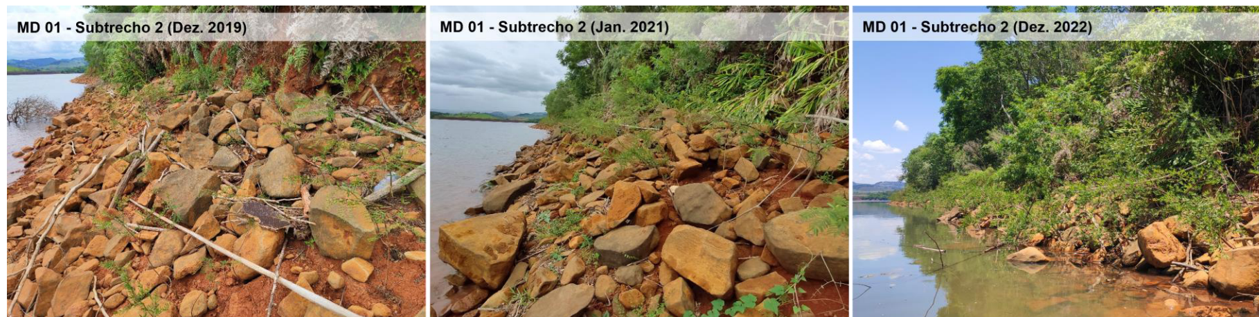
Figura 69 - Evolução das técnicas implantadas no trecho MD 01 (subtrecho 2) do reservatório da UHE Itá.
