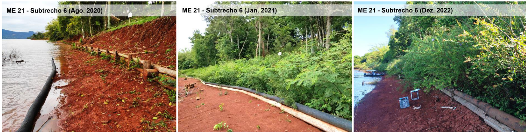
Figura 75 - Evolução das técnicas implantadas no trecho ME 21 (subtrecho 6) do reservatório da UHE Itá.
