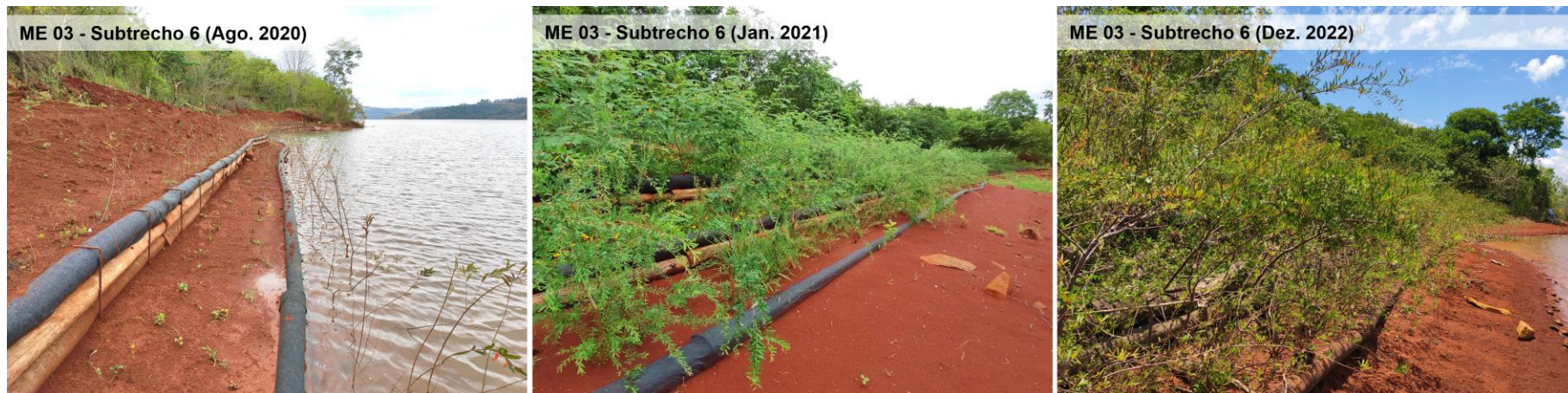
Figura 72 - Evolução das técnicas implantadas no trecho ME 03 (subtrecho 6) do reservatório da UHE Itá.
