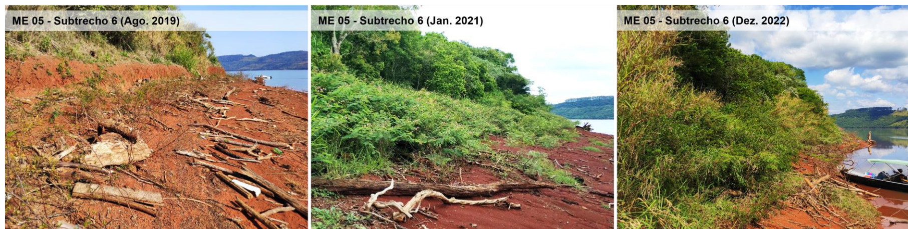
Figura 66 - Evolução das técnicas implantadas no trecho ME 05 (subtrecho 6) do reservatório da UHE Itá.
