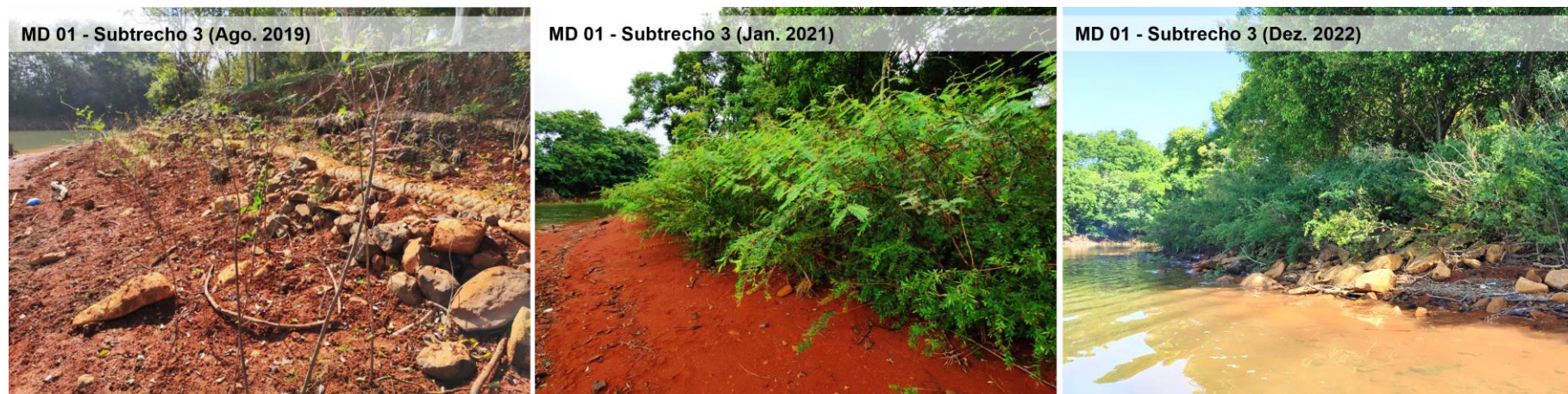
Figura 70 - Evolução das técnicas implantadas no trecho MD 01 (subtrecho 3) do reservatório da UHE Itá.
