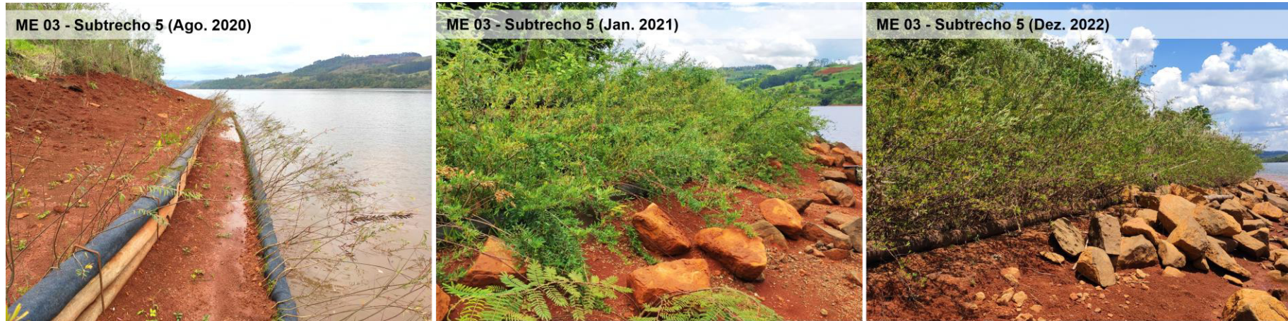
Figura 71 - Evolução das técnicas implantadas no trecho ME 03 (subtrecho 5) do reservatório da UHE Itá.
