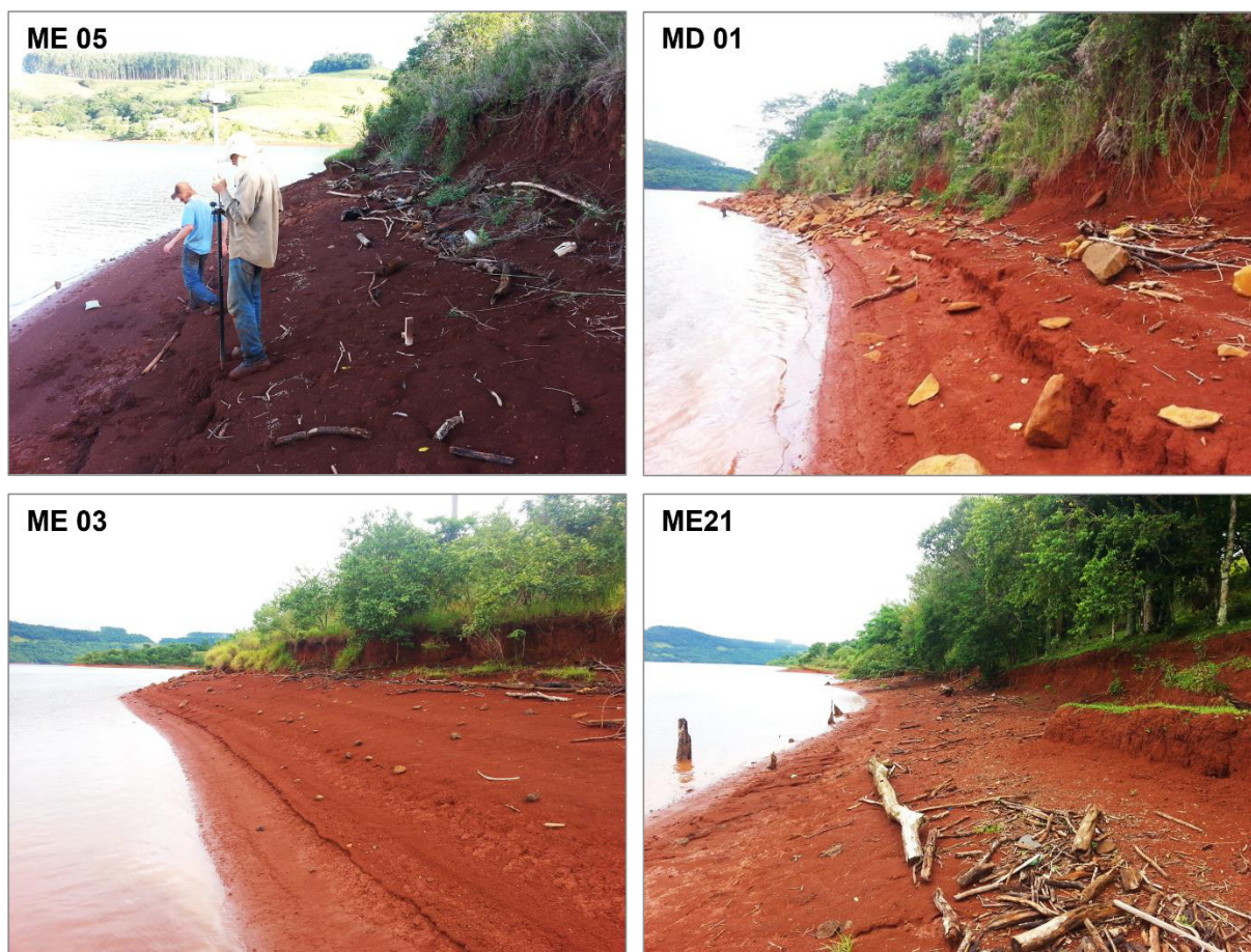
Figura 19 – Trechos experimentais (ME 05, MD 01, ME 03 e ME 21) para implantação de projetos piloto utilizando técnicas de Engenharia Natural no reservatório da UHE Itá.
