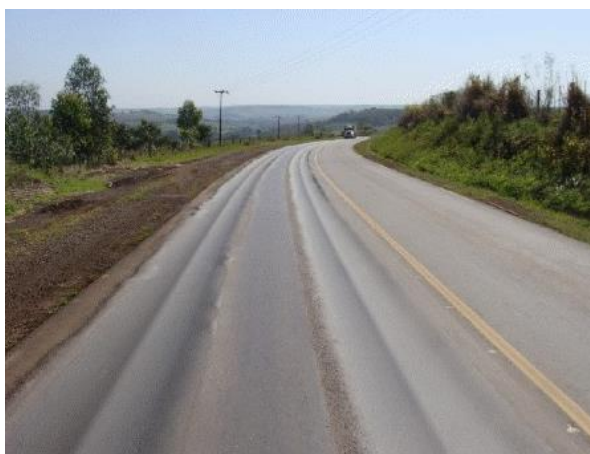
Figura 17 - Afundamentos por consolidação (trilha da esquerda) e plástico (trilha da direita)
