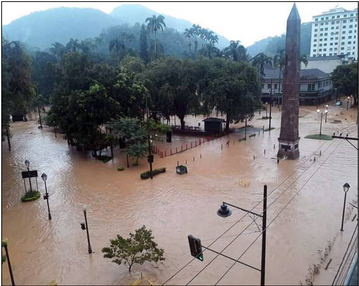
Figura 6 —Inundação no centro histórico da cidade de Petrópolis — RJ
