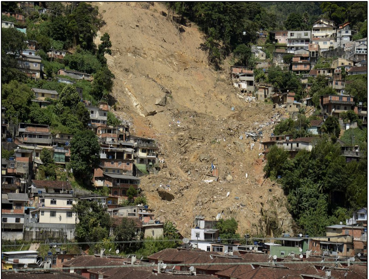
Figura 5—Movimento de massa causado pelas chuvas na cidade de Petrópolis — RJ
