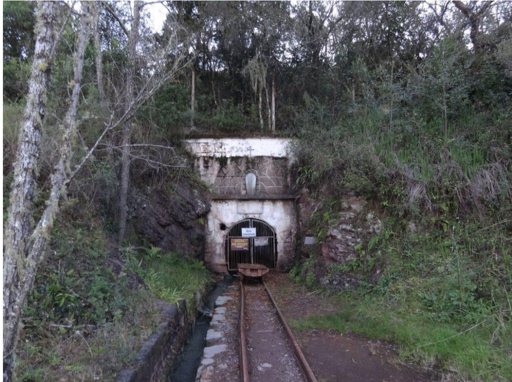
Figura 2 - Galeria dos Ingleses.
