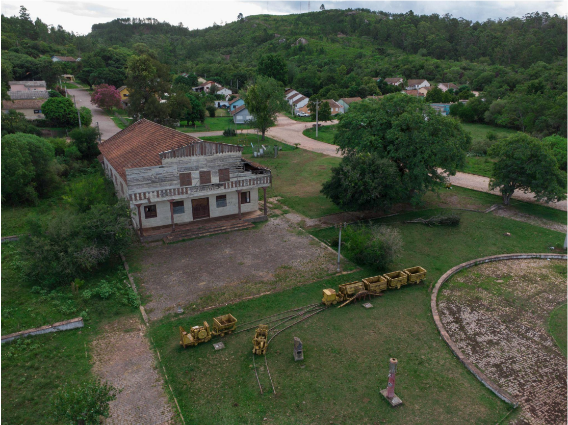
Figura 5 - Vista aérea do largo do Cine Rodeio em fevereiro de 2023.
