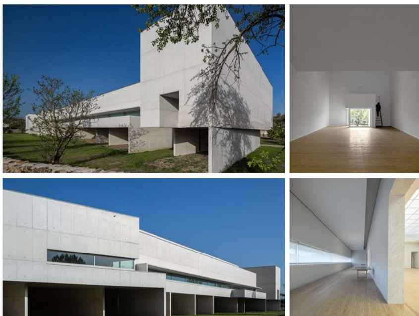
Figura 99 – Vistas externas e internas da janela em fita – Fachada Sudeste
