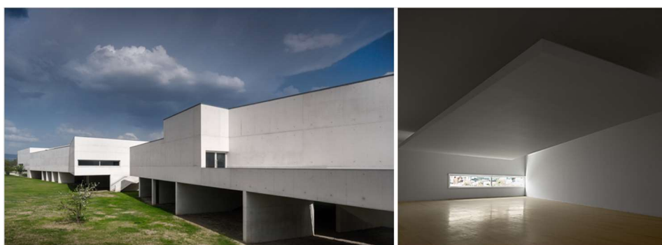
Figura 100 – Fenestração com vistas a rampa de entrada
