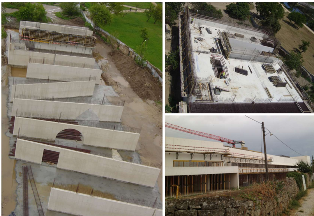
Figura 119 – Execução do MACNA
