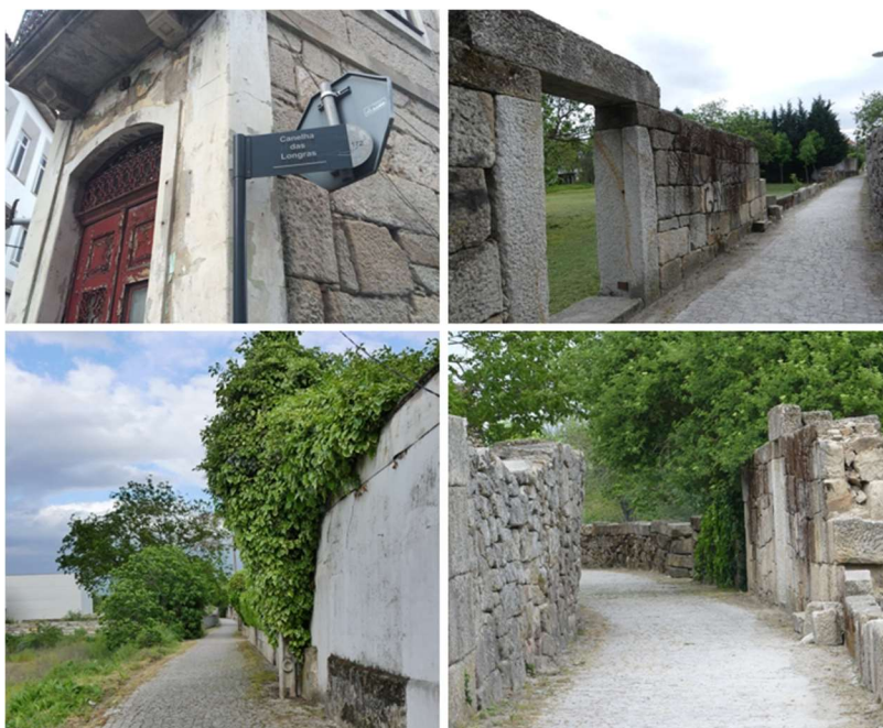
Figura 91 – Ruínas da Canelha das Longras
