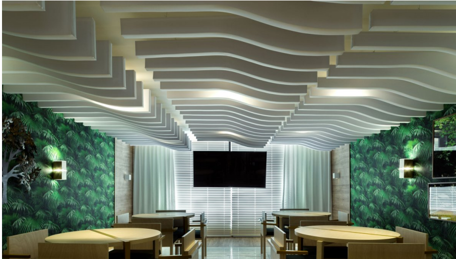
Figura 22 – Baffles instalados em uma sala de reuniões
