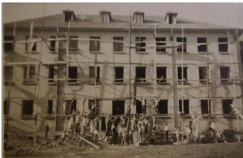
Figura 12 – Pré-Seminário São José - Faxinal do Soturno, em construção (1948)
