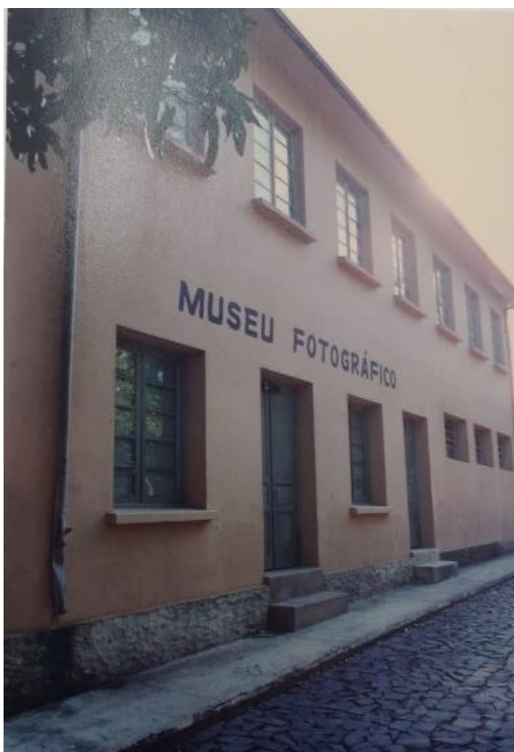
Figura 18 – Vista frontal do prédio onde encontra-se o Museu Fotográfico
