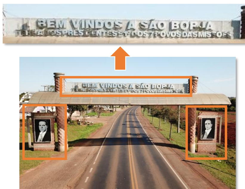
Figura 4 – Portal de acesso
