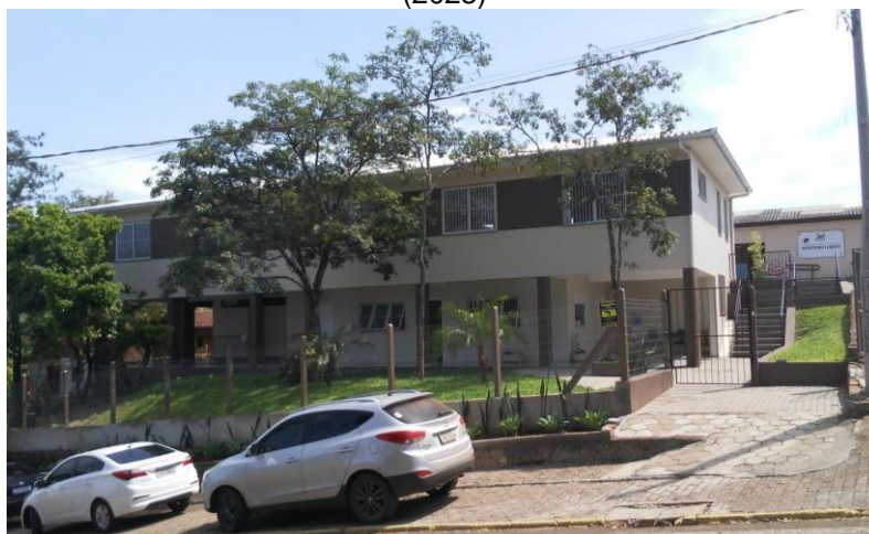
Figura 12 – Prédio da escola EMEF Monteiro Lobato em sua mais recente ampliação e reforma (2023)
