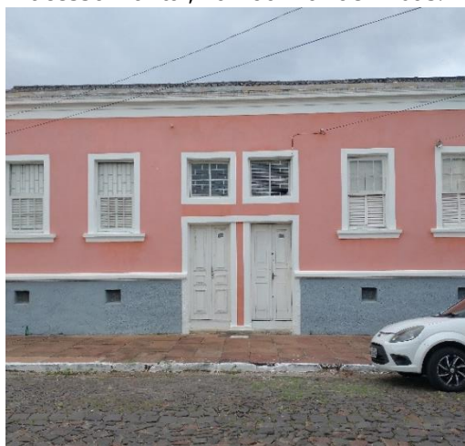
Figura 25: Residência sem recuo e com acesso frontal, na Rua Manoel Ribas.
