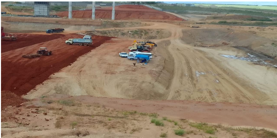
Figura 50 - Segmento das enscadeiras a jusante.
