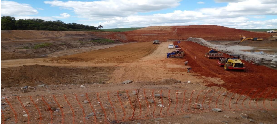
Figura 38- Execução de aterro compactado com argila no segmento das enseadeiras.
