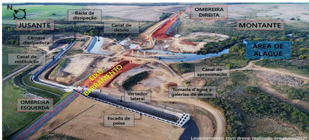
Figura 36- Barragem Jaguari na 2 fase do projeto de desvio.
