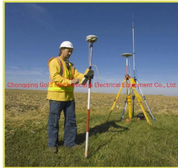
Figura 9- Alocação de receptores GNSS.
