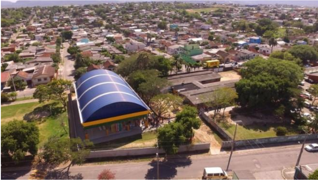
Figura 1 - Vista aérea da EEEB Augusto Ruschi.
