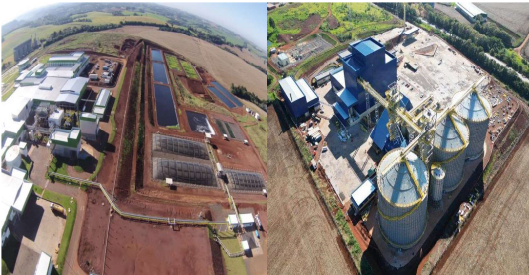
Figura 4: Instalações do frigorífico e Fábrica de Ração da JBS em Seberi-RS.
