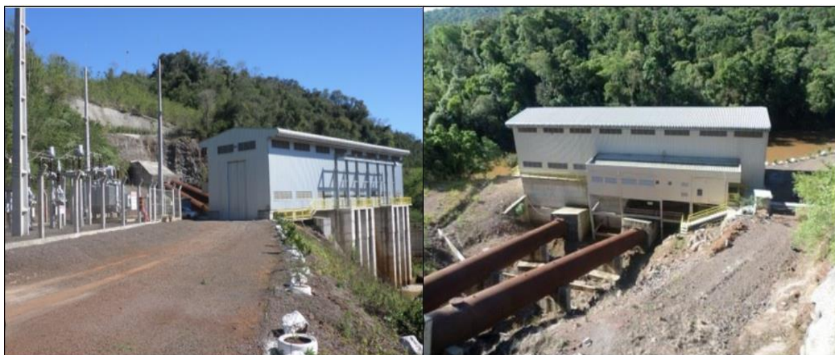
Figura 11 - Casa de Força da PCH Tambaú.
