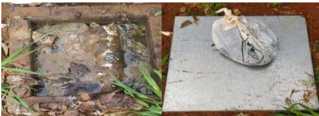
Figura 22: Limpeza da caixa de gradeamento após 45 dias de operação.
