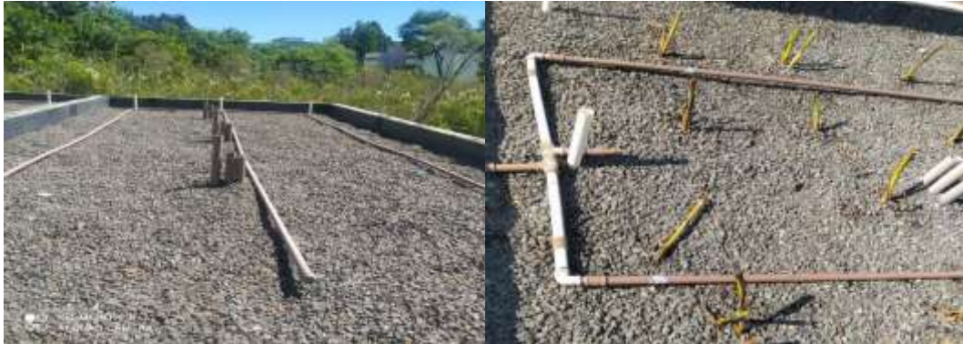
Figura 18: Mudança realizada da tubulação de distribuição
