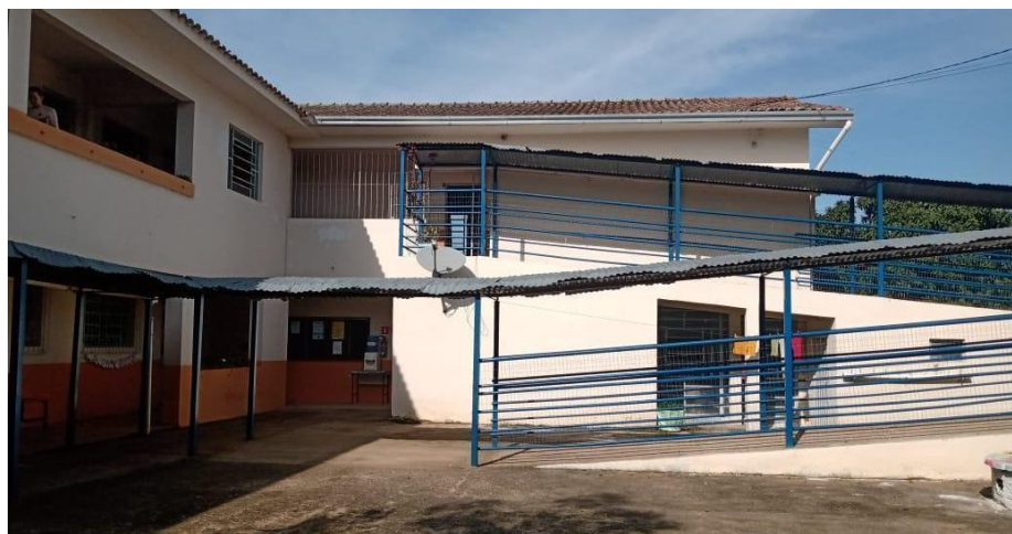
Figura 9 - EMEF Dezidério Fuzer com as ampliações
