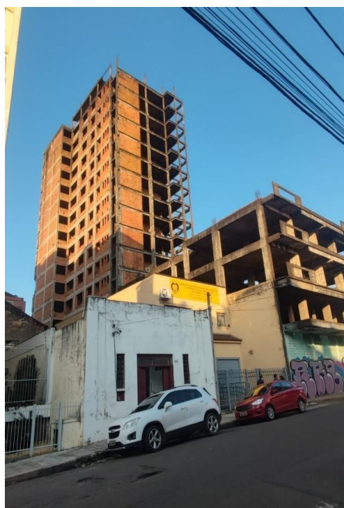
Figura 23– Fachada da edificação
