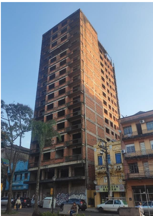
Figura 22 – Fachada da edificação
