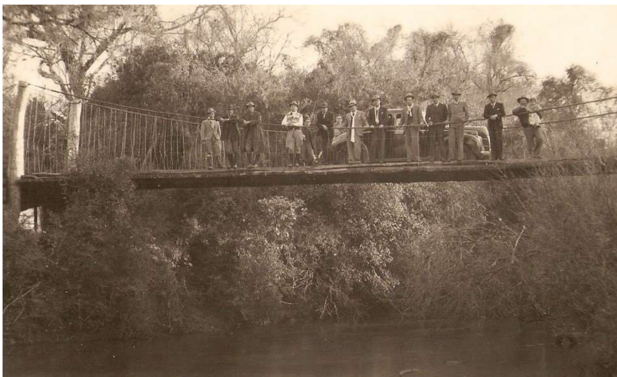
Figura 20 – Ponte Pênsil sobre o Arroio Pitangueira em Caçapava do Sul, 1927.
