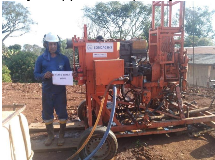
Figura 3 - Equipamento utilizado para sondagem SPT
