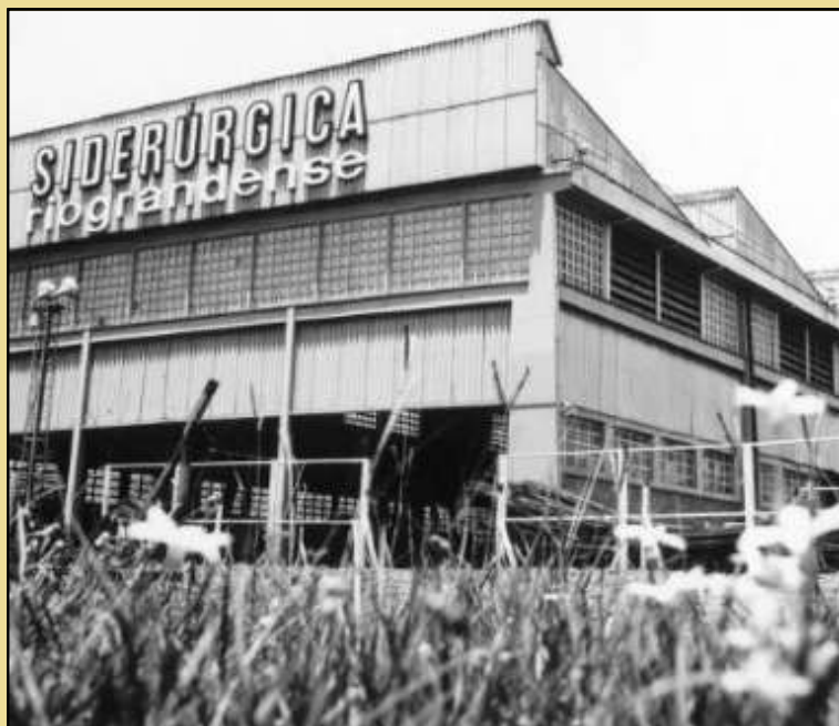
Complexo Industrial da Siderúrgica Riograndense, atual Gerdau, em 1948. Fonte: GERDAU, 2021.
