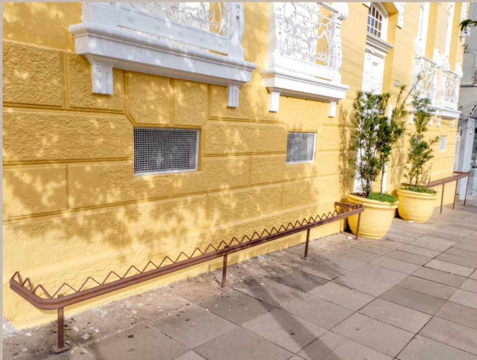
Ferragens fixadas na fachada de um prédio histórico na Avenida Rio Branco.
