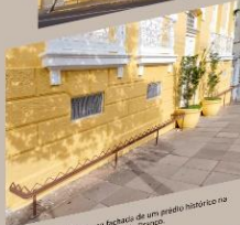
Ferragens fixadas na fachada de um prédio histórico na Avenida Rio Branco.
