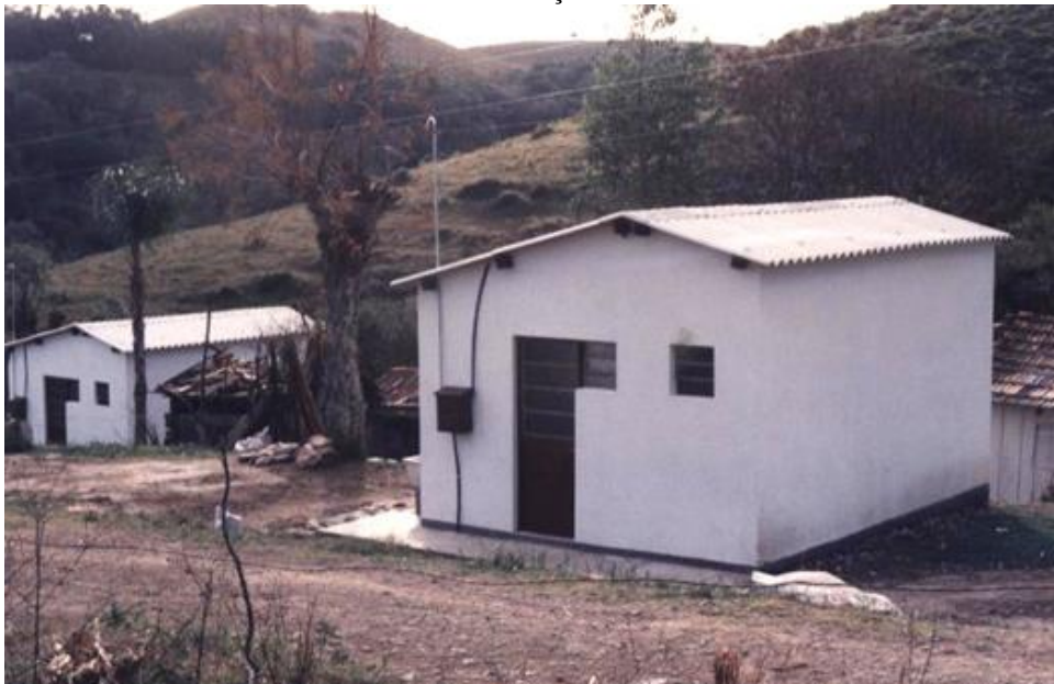
FIGURA 5 – Início das Construções das Casa com materiais
