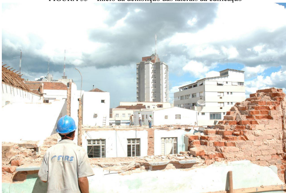
FIGURA 35 - Início da demolição das laterais da edificação
