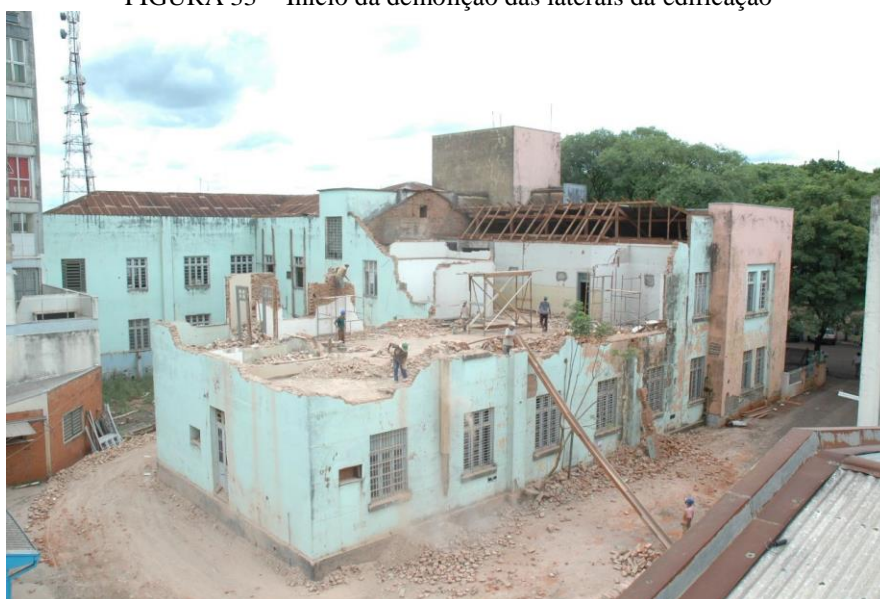
FIGURA 33 - Início da demolição das laterais da edificação
