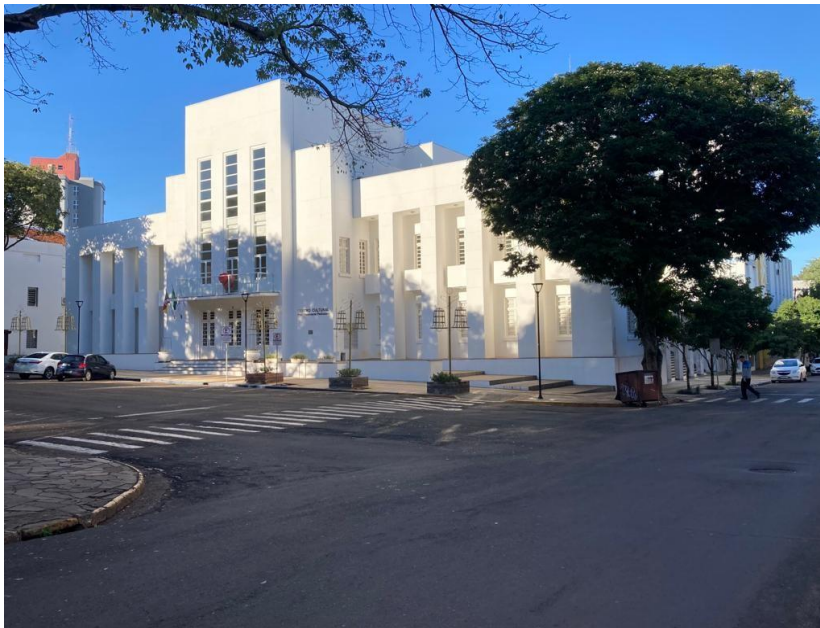
FIGURA 38 - Fachada frontal do Centro Cultural Professor Fioravante Pedrazzani
