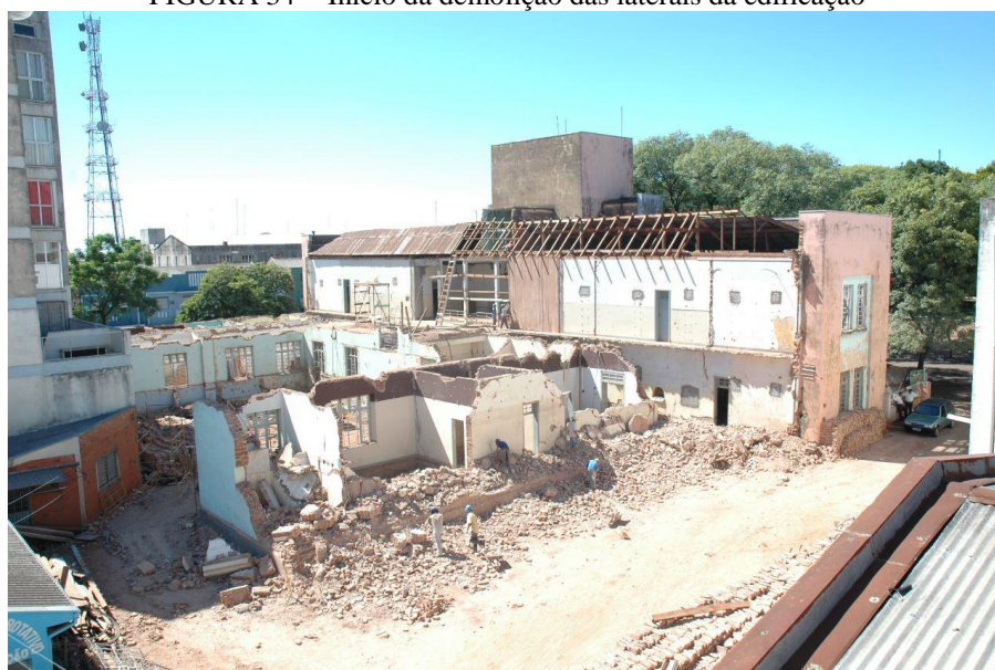
FIGURA 34 - Início da demolição das laterais da edificação
