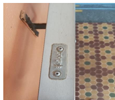
Arquivo pessoal da autora – Corrimão das escadas da escola com sinalização em braille.
