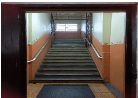
Arquivo pessoal da autora – Escadas da escola
