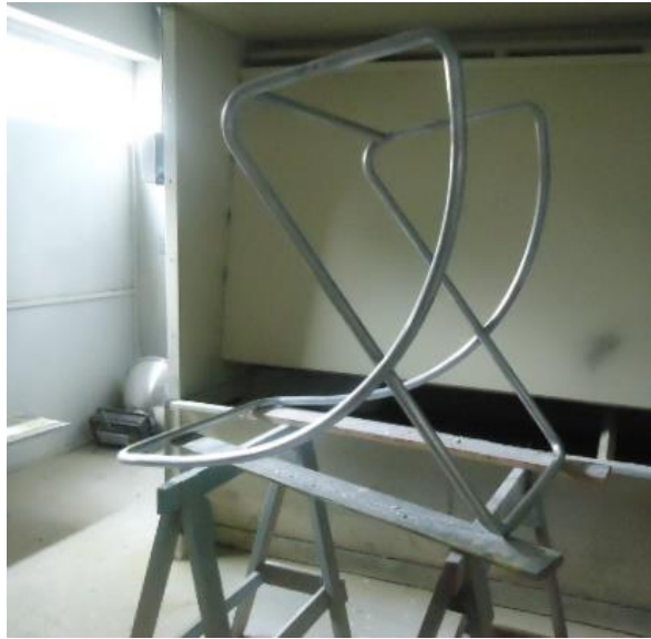
Figura 86 - Preparação da estrutura para a pintura.
