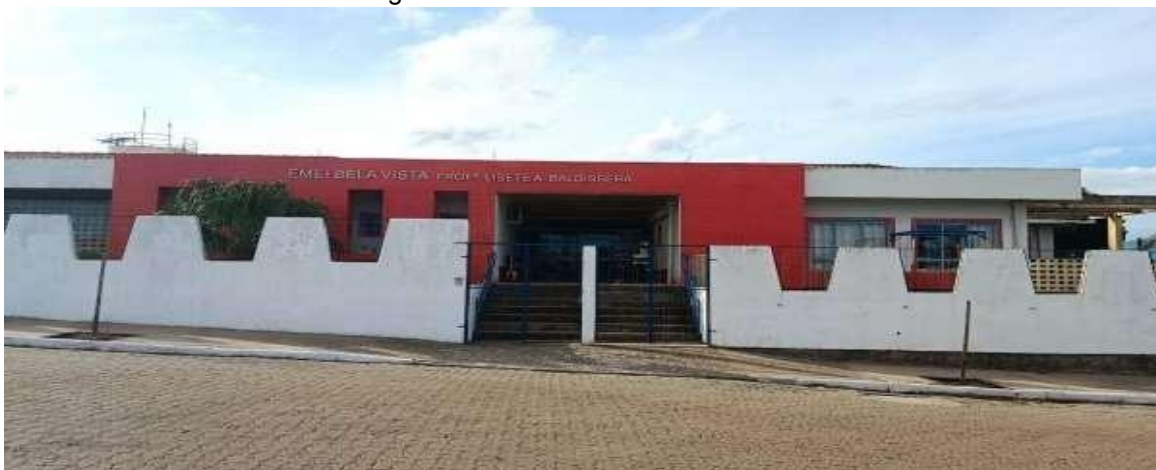
Figura 4 – Fachada da EMEI Bela Vista
