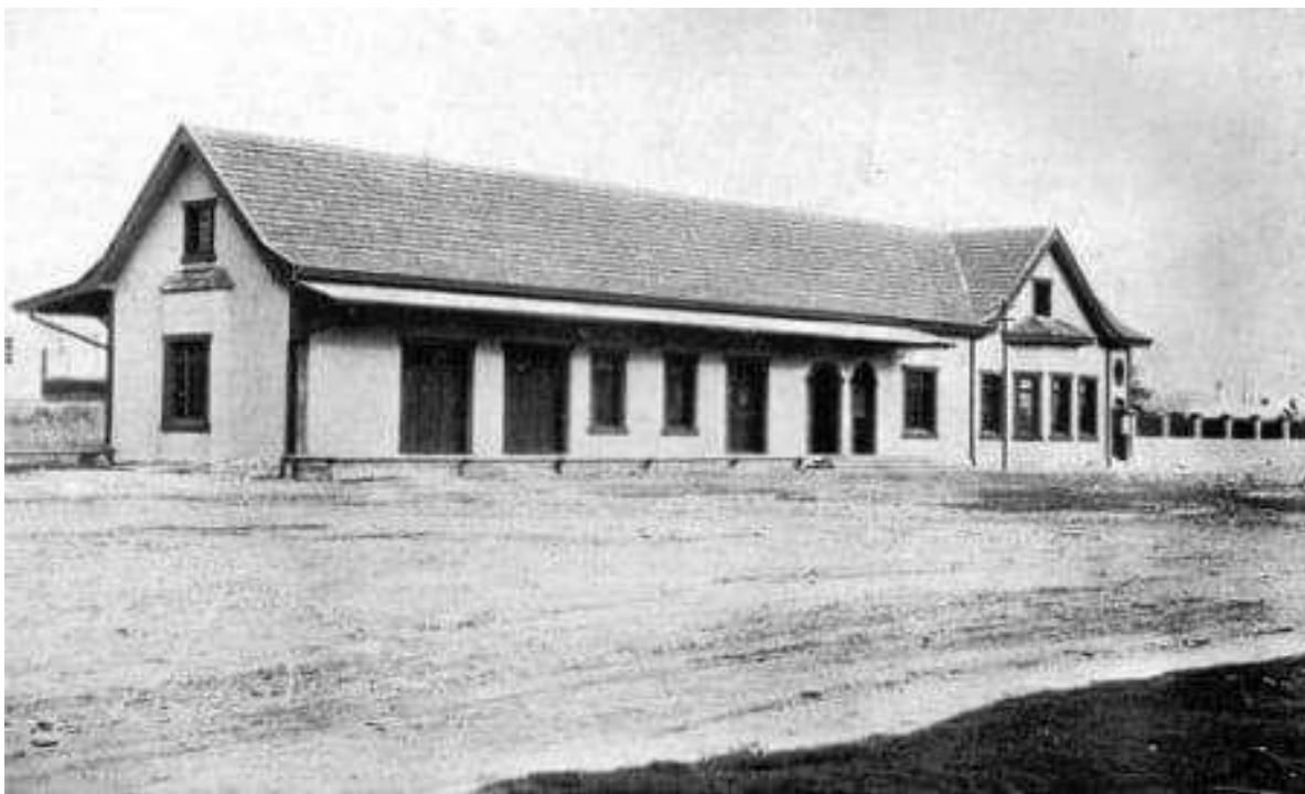
Figura 8 – Prédio recém terminado da Estação de Restinga Sêca, em 1926 (a
