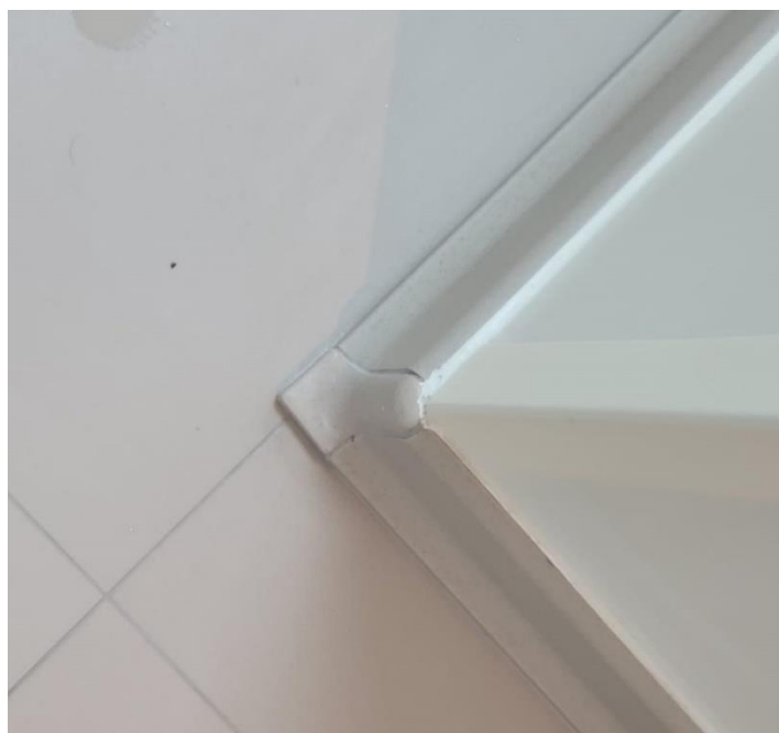
Figura 36 - Instalação rodapé curvo piso porcelanato
