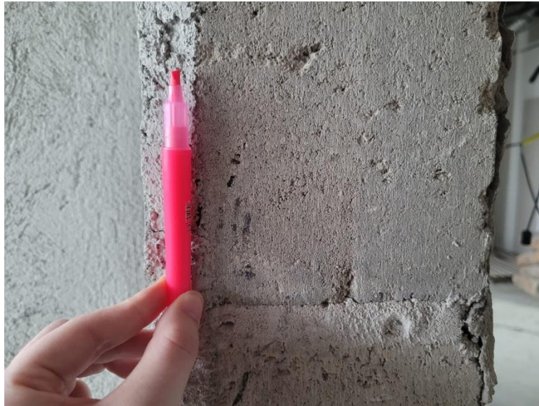
Figura 59 - Espessura do reboco baritado
