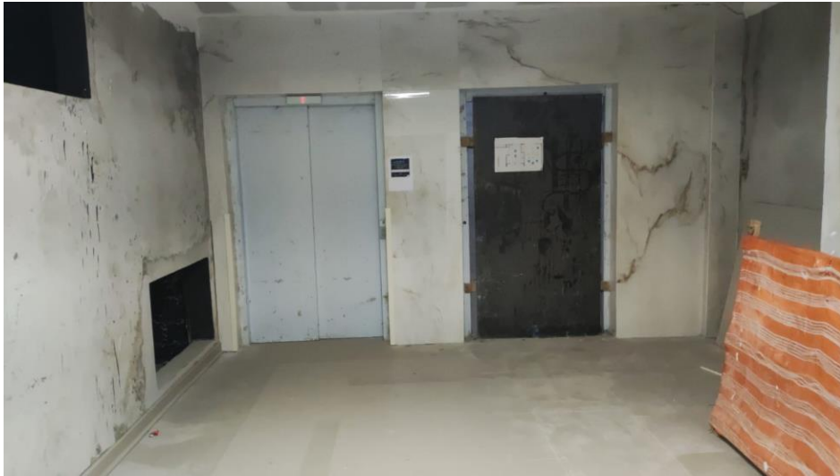
Figura 58 - Dutos de ventilação antecâmara
