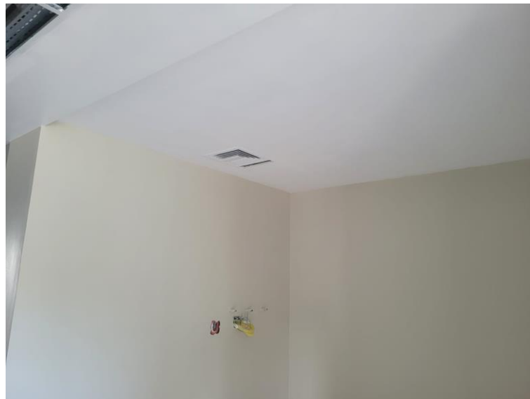
Figura 27 – Pintura de paredes e teto
