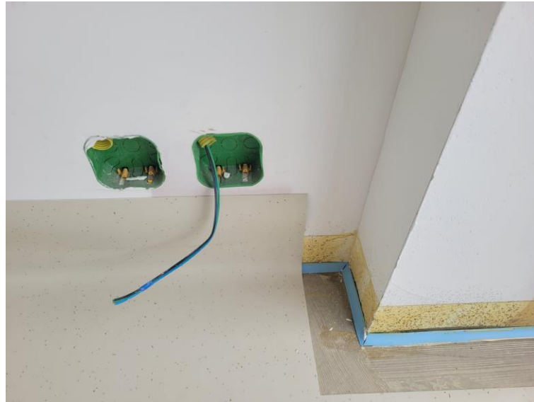
Figura 35 - Instalação rodapé curvo piso vinílico
