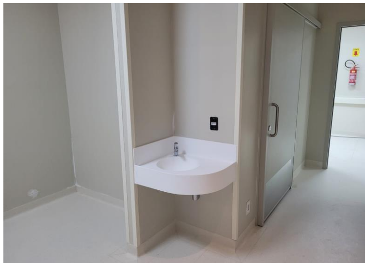
Figura 14 - Lavatório do quarto de internação
