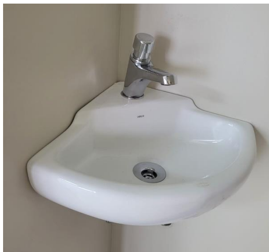
Figura 10 - Lavatório dos boxes de atendimento
