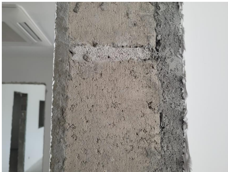
Figura 60 - Comparação espessura reboco comum e reboco baritada
