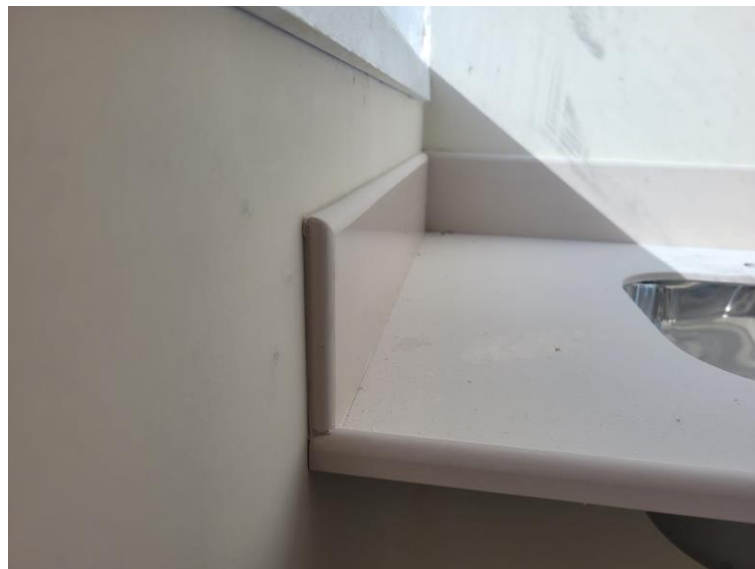
Figura 30 - Detalhe do boleamento na bancada em porcelanato
