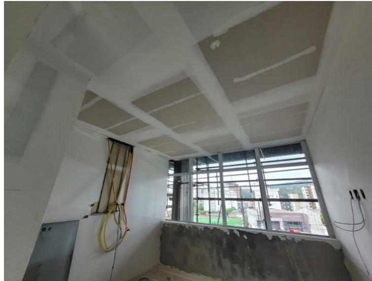
Figura 38 - Execução forro monolítico
