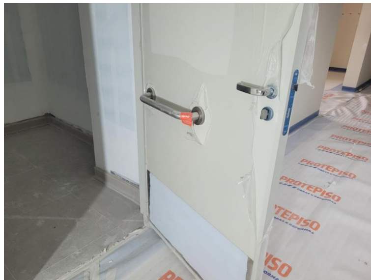
Figura 53 - Barra horizontal da porta do sanitário
