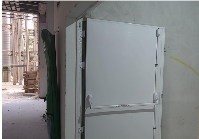
Figura 56 - Porta corta-fogo antecâmara
