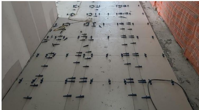
Figura 33 - Instalação piso porcelanato
