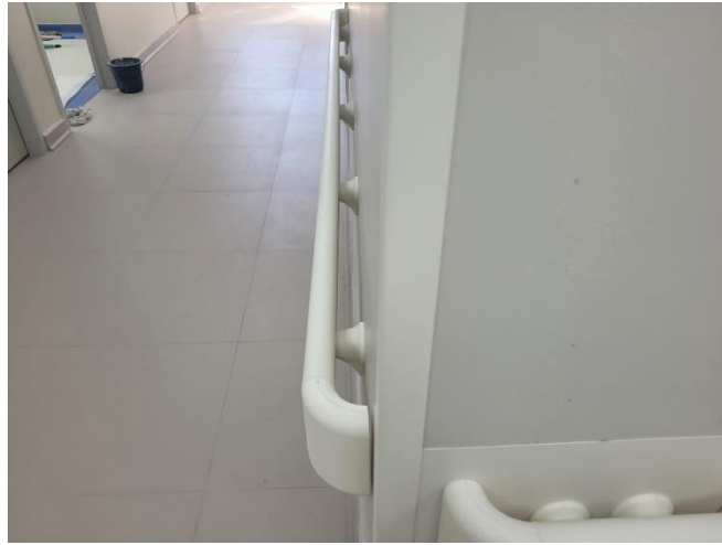
Figura 45 - Acabamento curvo do corrimão
