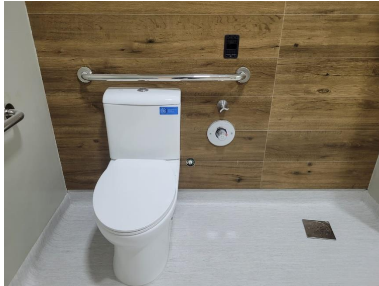
Figura 41 - Espera para ducha higiênica e misturador termostato
