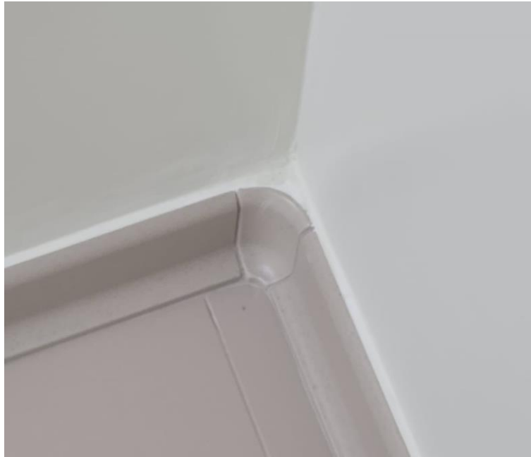
Figura 37 - Instalação rodapé curvo piso porcelanato
