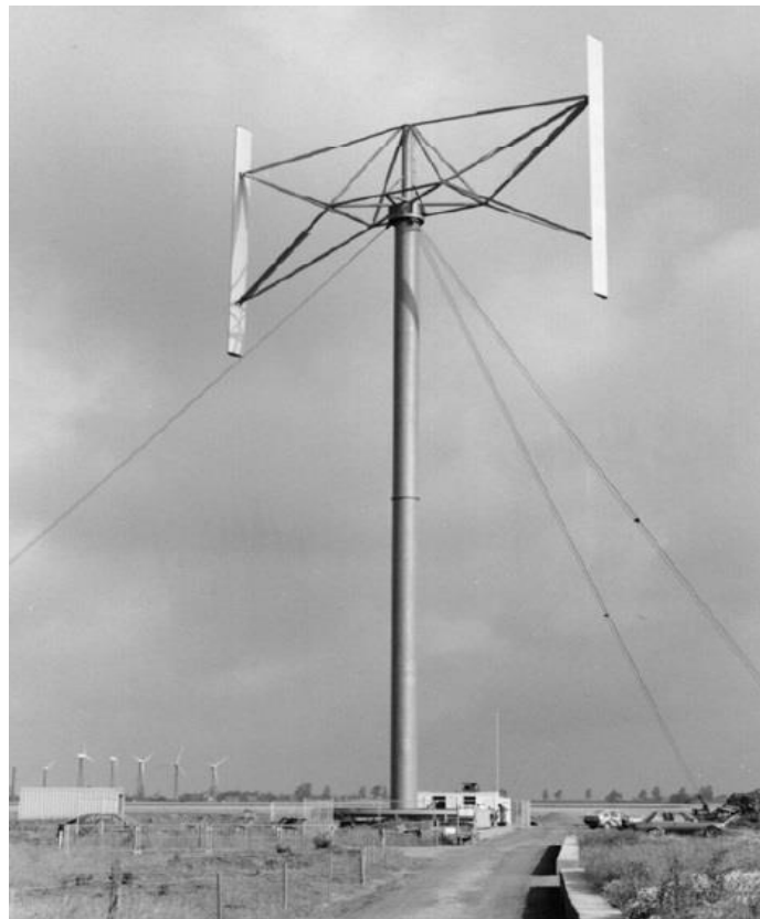
Figura 13 – Modelo de turbina Darrieus H.
