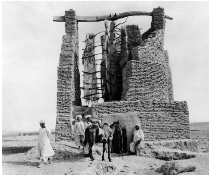
Figura 4 - Moinho de vento de eixo vertical para moagem de grãos, Afeganistão.
