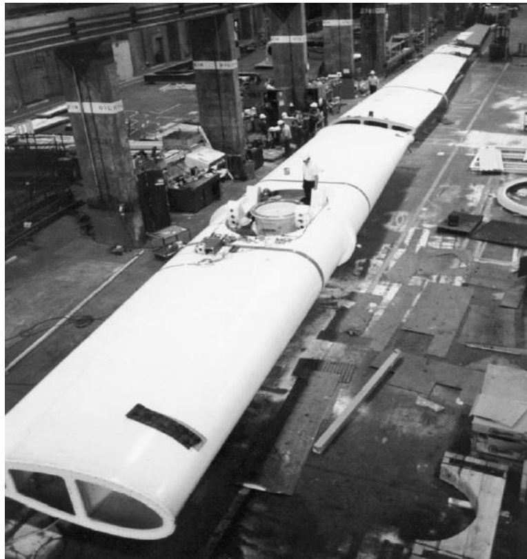
Figura 10 - Fabricação de uma das pás da turbina americana MOD-2.
