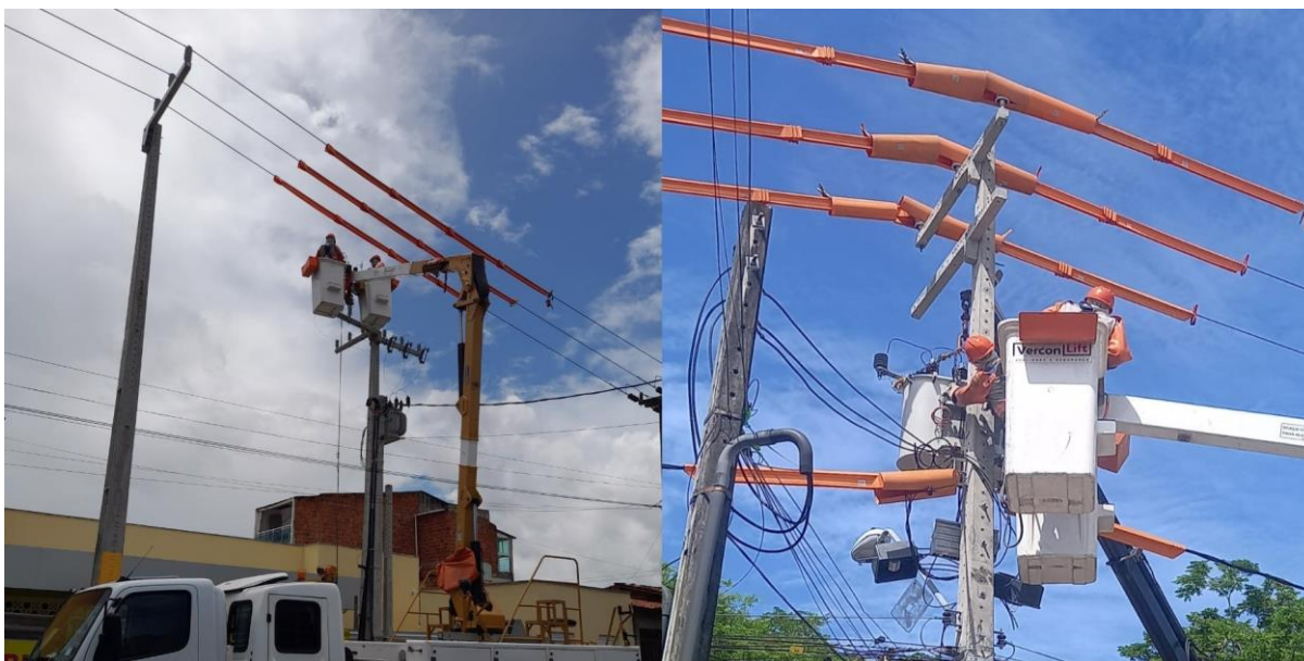
Figura 2 – Trabalhadores executando atividades de Linha Viva
