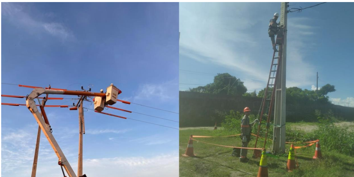
Figura 5 – Atividade de Linha Viva sendo realizada em cesto aéreo, a esquerda. A direita, atividade de Linha Morta sendo realizada através de escada extensível.
