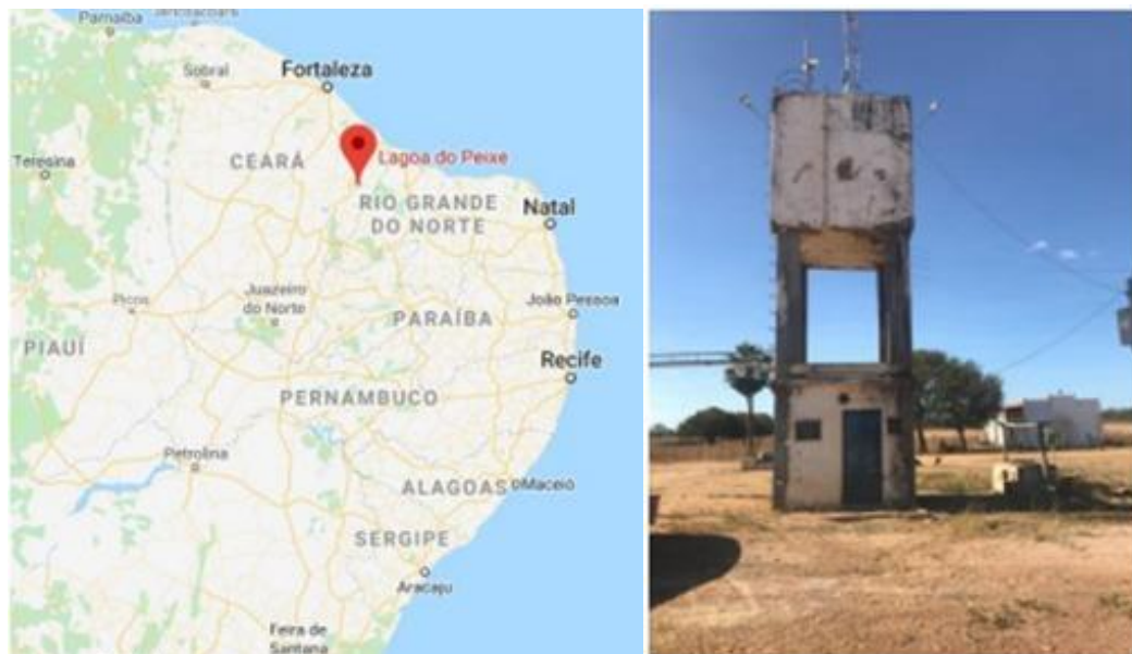
Figura 11 - Reservatório de Água da Lagoa do Peixe – Tabuleiro do Norte (CE)
