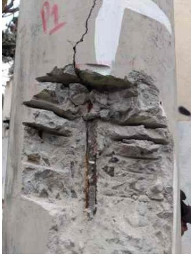
Figura 8 - Abertura de janelas no pilar
