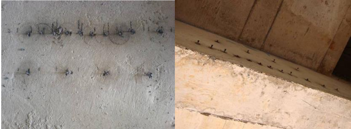
Figura 28 - Ensaio realizado na viga e na laje da obra B
