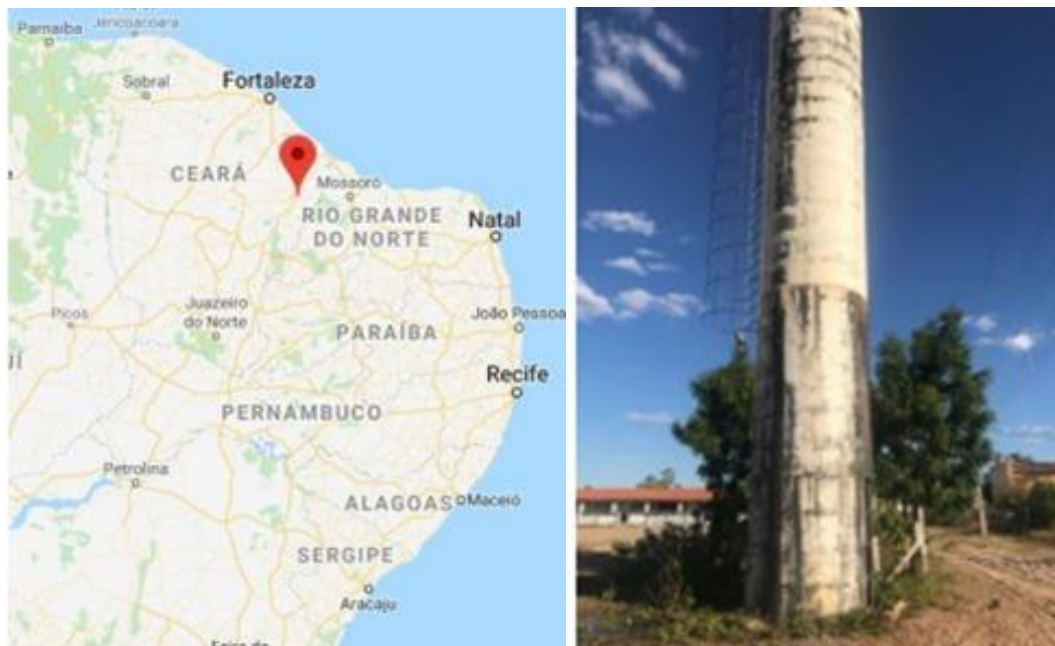
Figura 10 - Reservatório de água de Água Santa – Tabuleiro do Norte (CE)
