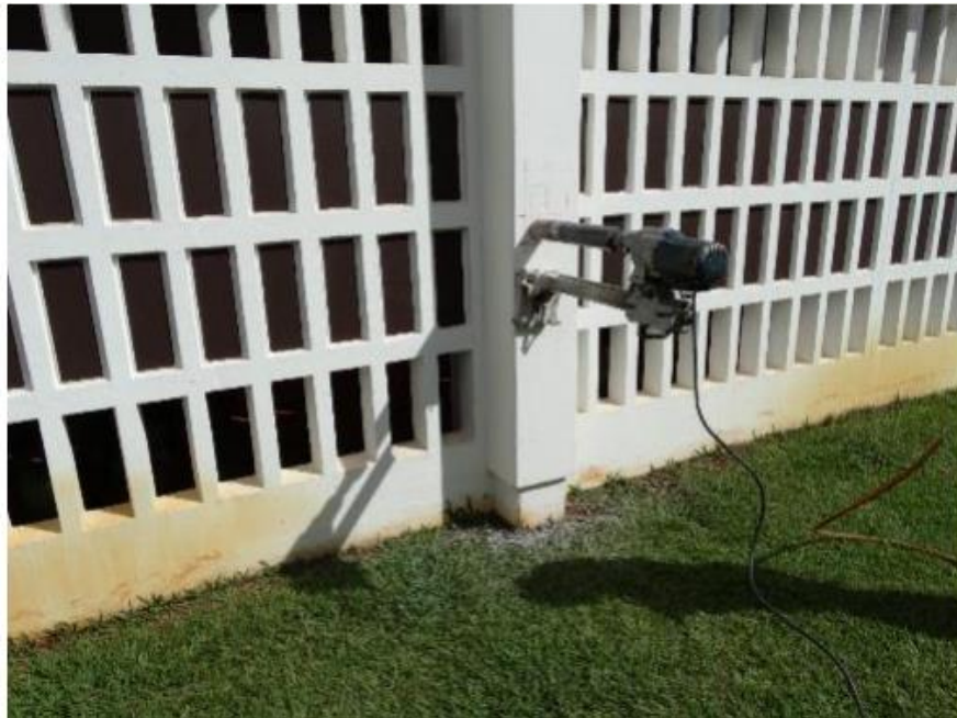
Figura 1 - Realização de extração de testemunho do pilar da edificação principal antiga
