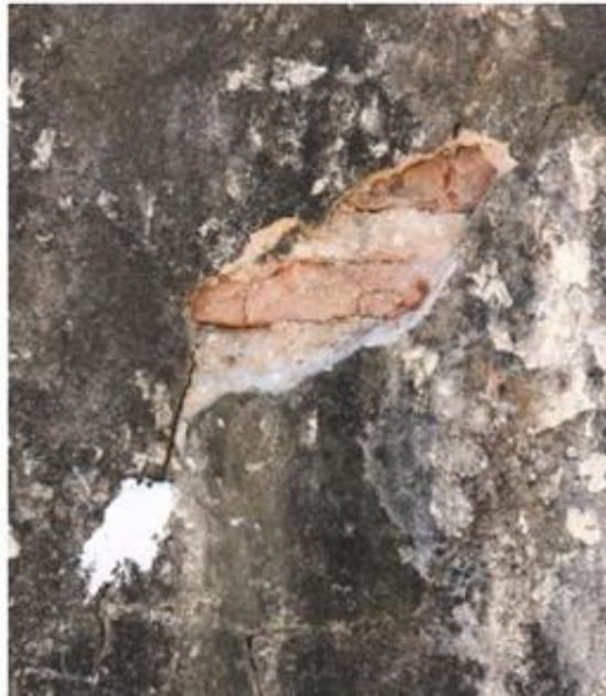
Figura 12 - Abertura de janela de inspeção
