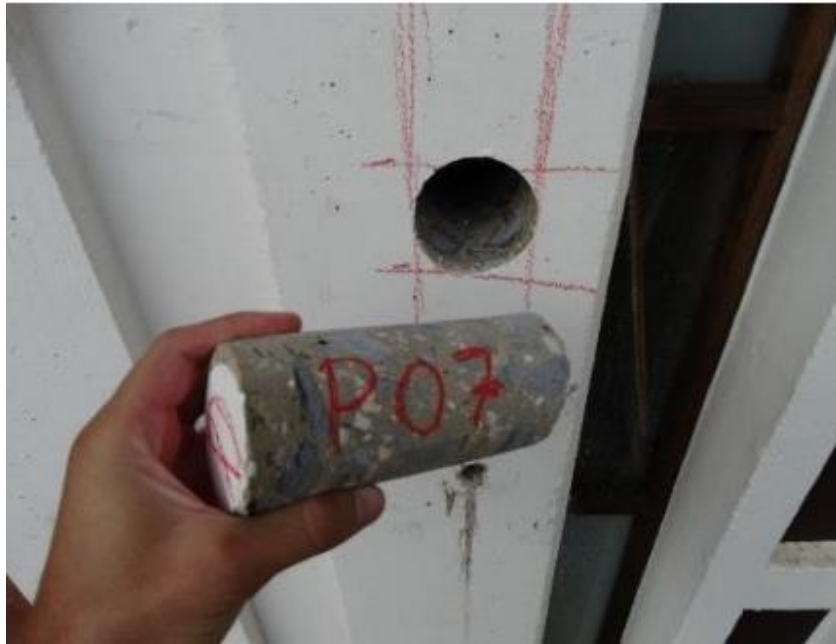
Figura 2 - Realização de extração de testemunho do pilar
