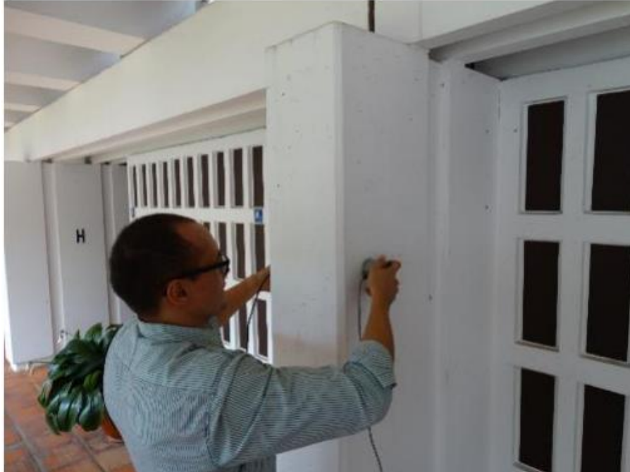
Figura 45 - Realização de ensaio de ultrassonografia em Pilar de Concreto Armado
