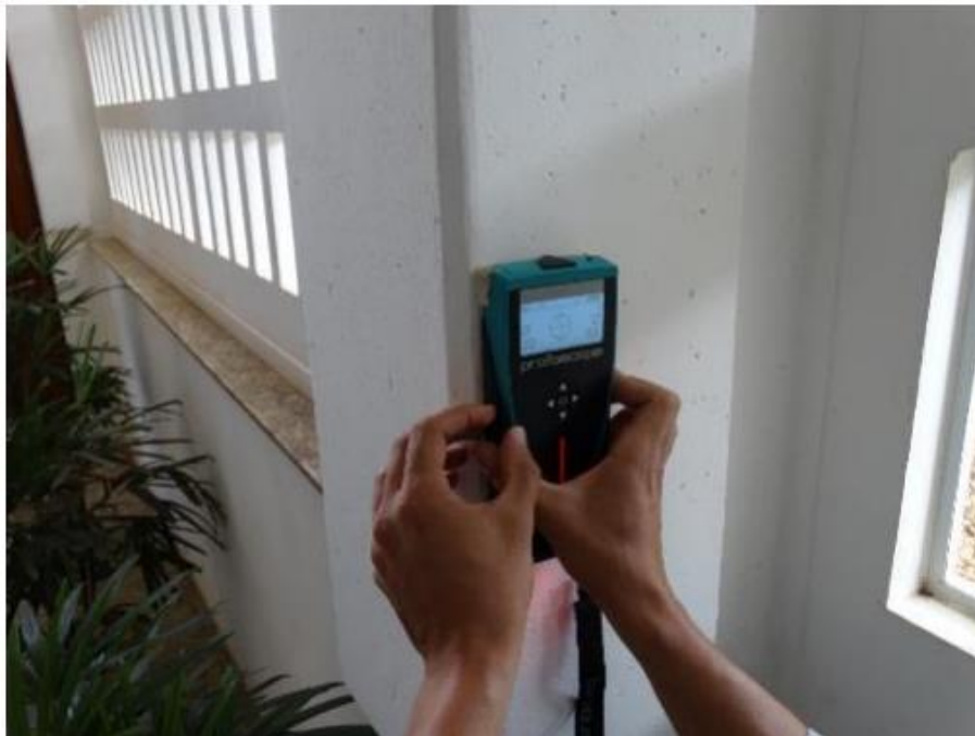
Figura 21 - Ensaio de pacômetria em pilar de concreto
