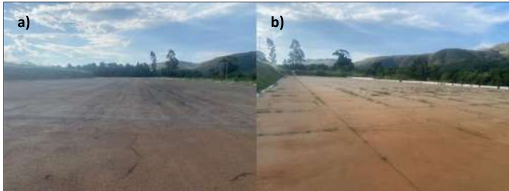
Figura 23 – a) Terreiro de asfalto e b) novo terreiro de cimento.
