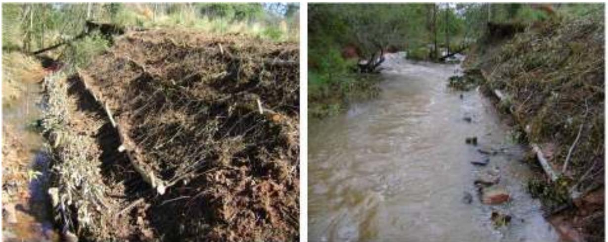
**Figura 11** – Margem da Sanga Lagoão do Ouro uma semana após a construção da obra de bioengenharia de solos, Santa Maria – RS.
