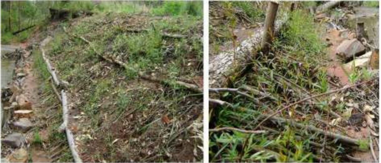
**Figura 12** – Margem da Sanga Lagoão do Ouro dois meses após a construção da obra de bioengenharia de solos, Santa Maria – RS.
