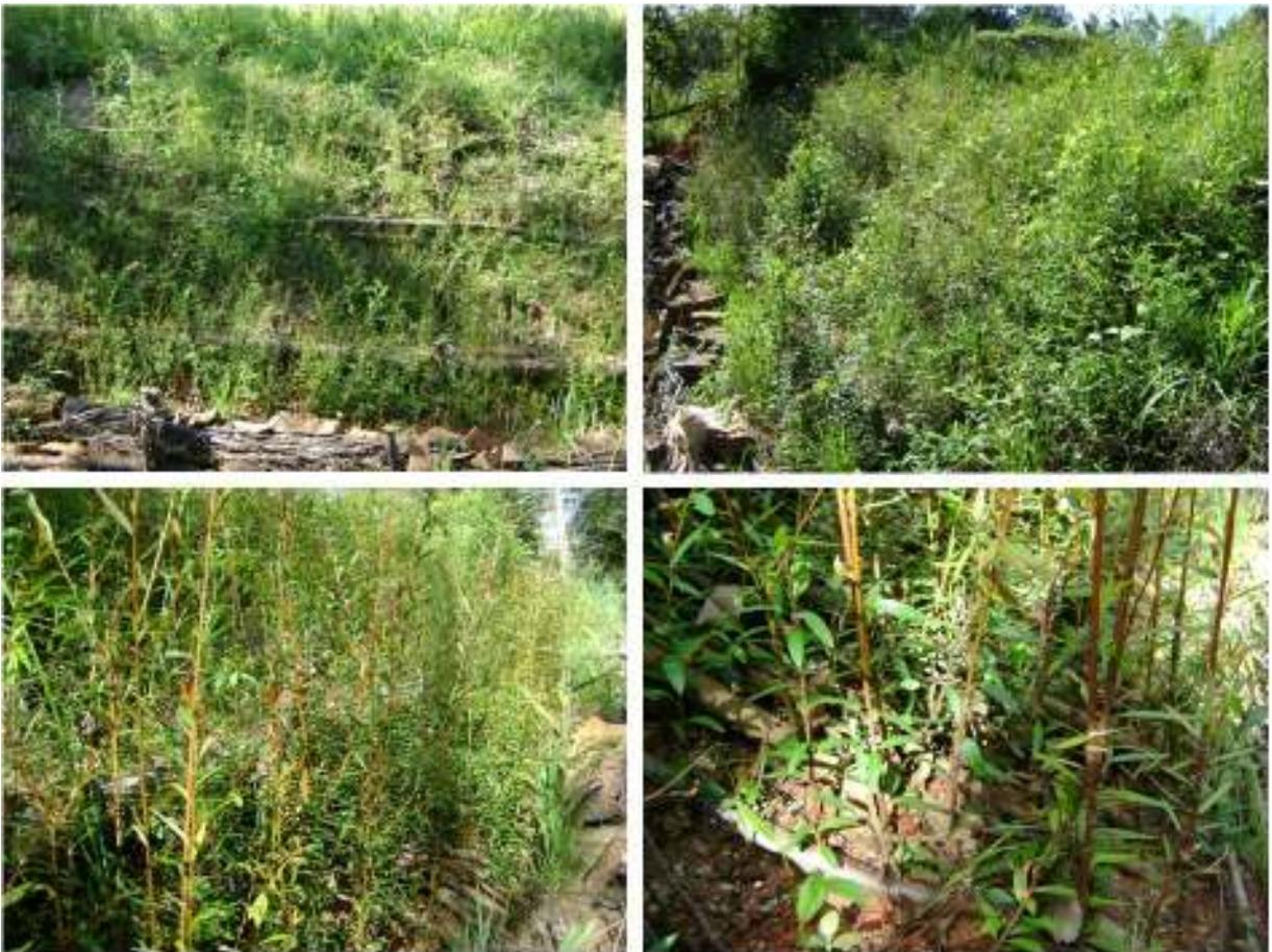
**Figura 13** – Margem da Sanga Lagoão do Ouro quatro meses após a construção da obra de bioengenharia de solos, Santa Maria – RS.
