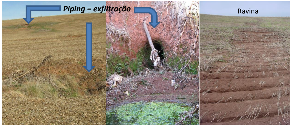
Figura 1. Erosão subsuperficial e superficial na pequena bacia hidrográfica (Fonte: Capoane e Pellegrini, 2010).
