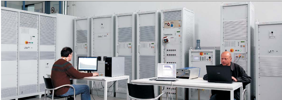
Figura 28: Simulador de LVRT de 90 kVA, DeMoTec-IWES.
