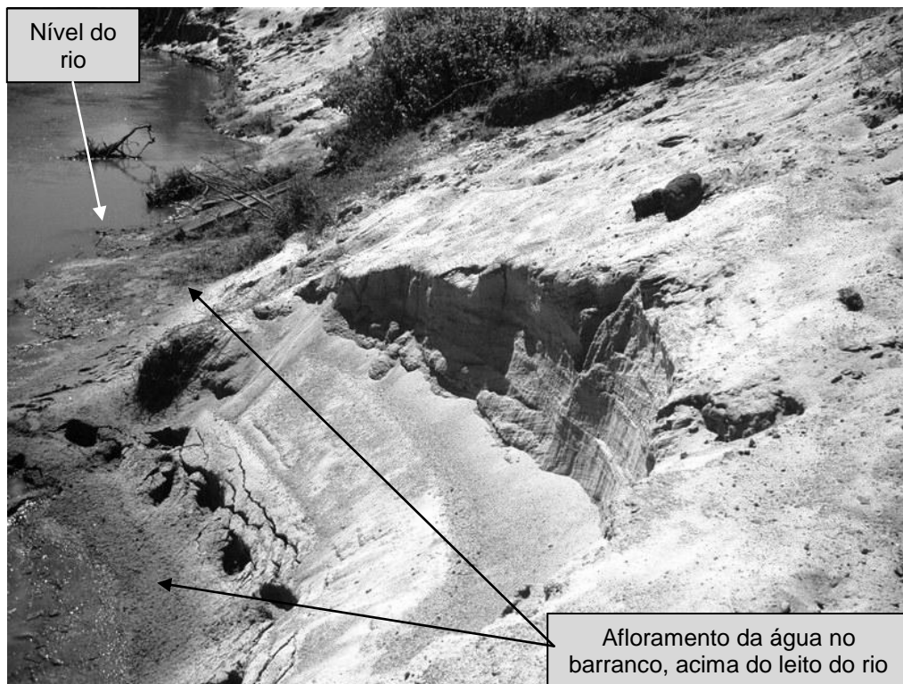
Figura 21 – Barranco em queda, com a presença de zona de impedimento ao deslocamento vertical da água no solo. Cachoeira do Sul, RS.
