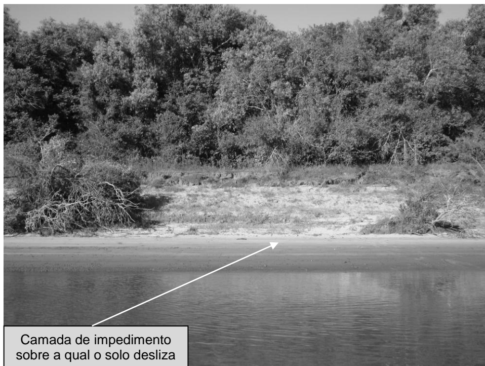
Figura 22 – Barranco em escorregamento, com a presença de zona de impedimento ao deslocamento vertical da água no solo. Local Bexiga, Cachoeira do Sul, RS.
