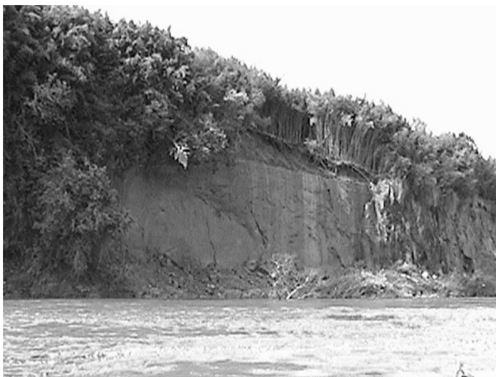
Figura 19 – Barranco em queda, em siltito, devido à infiltração e a presença de zona de impedimento ao deslocamento vertical da água no solo. Local Paredão do Cemitério das Irmandades. Cachoeira do Sul, RS.
