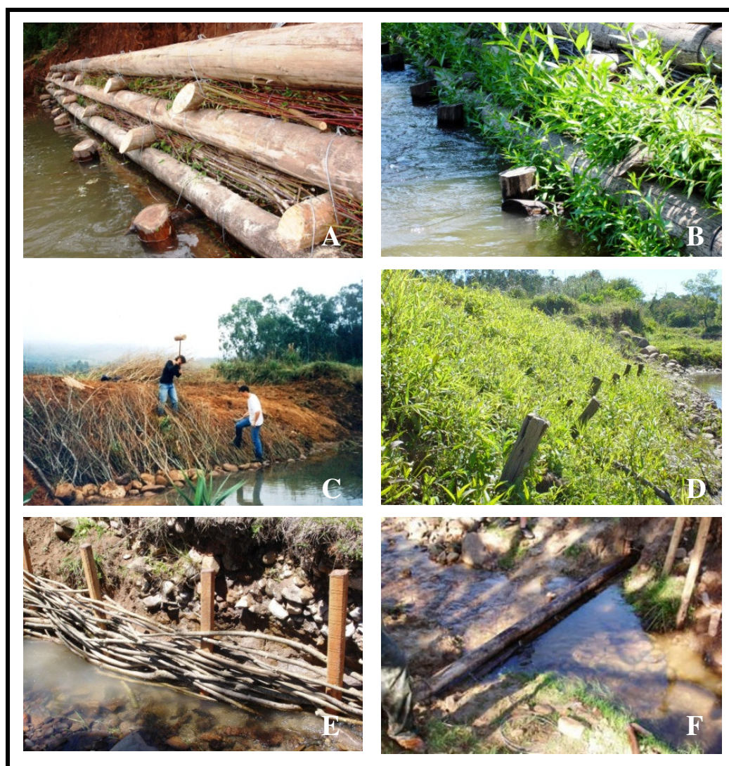
Figura 3 – Tipos de obras de Bioengenharia: A, B – parede Krainer; C, D – esteira viva; E – trança viva; F – soleira (Fotos: Fabrício Jaques Sutili).
