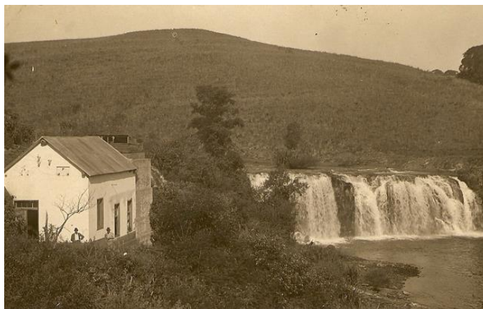
Figura 13 - Usina de Arroio Alegre, fundação em 27/09/1926
