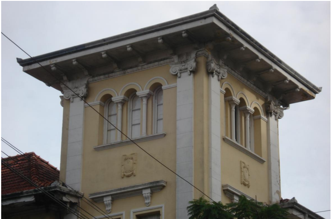
Figura 6 – Torreão. Alto do prédio, R. Santa Terezinha, nº. 79, Porto Alegre-RS. Fonte Ana Zavadil
