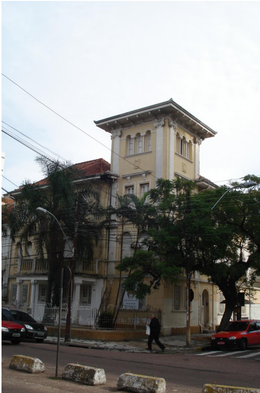
Figura 5 – Torreão. Prédio na esquina da R. Santa Terezinha com a Av. Venâncio Aires Fonte: Ana Zavadil
