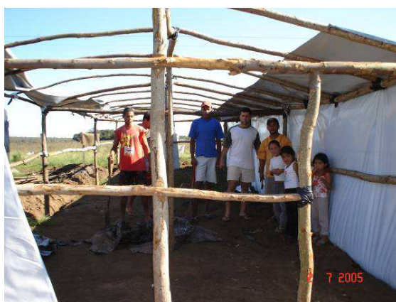
Fotografia 3: Construção da escola junto ao Acampamento Fonte: Trabalho de Campo – 02/07/2005
