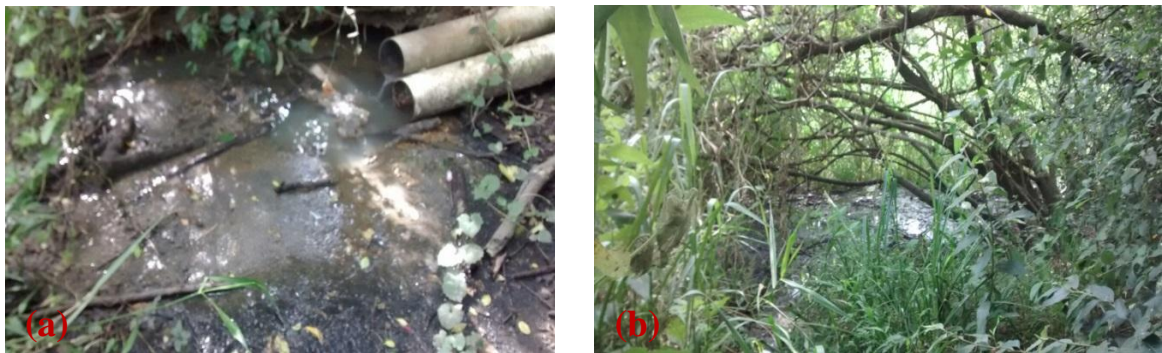
Figura 4 – (a) Tubos de passagem de águas residuais do prédio 36. (b): Local onde está a passagem do fluxo de esgoto bruto lançado pelos tubos da FP 50.
