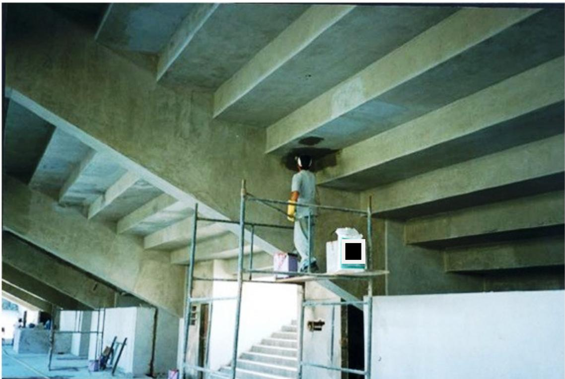
**Figura 3.4 – Aplicação do tratamento obturador de poros aplicado nas arquibancadas do estádio do Pacaembu (Site do fabricante, 12/07/2010)**
