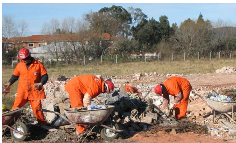
Figura 35 – Ações de prevenção na ATT de Santa Maria: operários devidamente equipados com EPI e, ao fundo, cercamento e barreiras verdes para proteção da área. Fonte: Acervo GR2 (2010).
