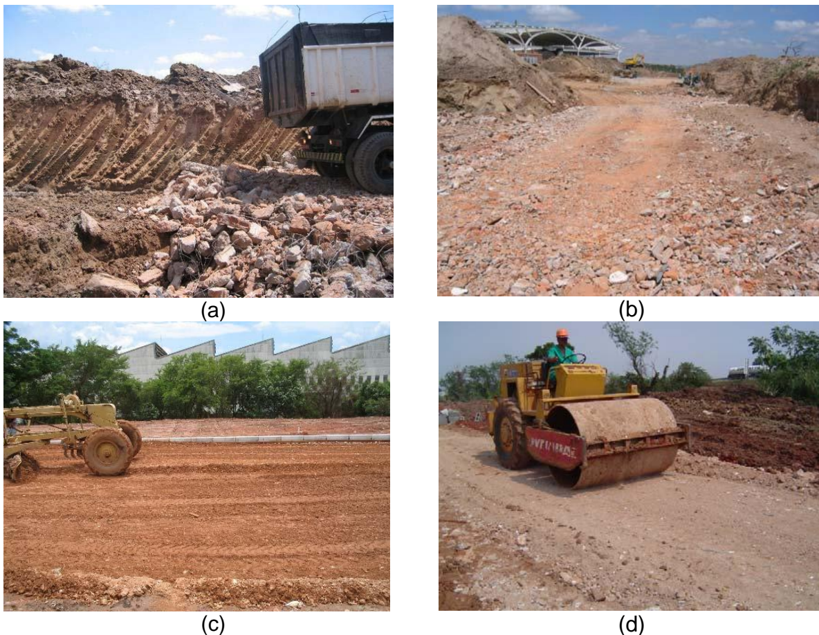
Figura 16 – Utilização de agregados reciclados em pavimentação: (a) “rachão de entulho” colocado sobre o subleito, (b) camada de “rachão de entulho” compactada, (c) motoniveladora espalhando o agregado reciclado e (d) compactação do agregado reciclado.
