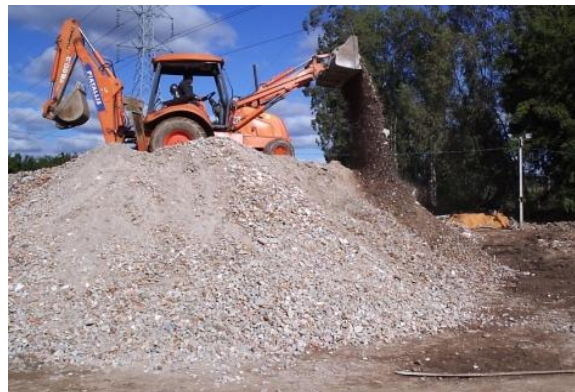
Figura 65 – Agregado reciclado disponível para comercialização. Fonte: Acervo do Autor (2010).
