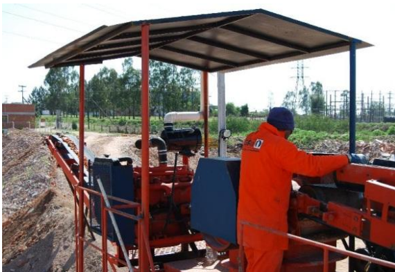
Figura 64 – Retirada de contaminantes menores na esteira de alimentação. Fonte: Acervo GR2 (2011).
