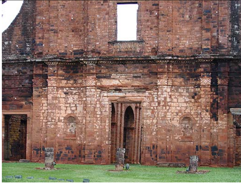
Figura 14. Conjunto I - Fachada da Ruína (externa, Norte). Fonte: Foto do Autor
