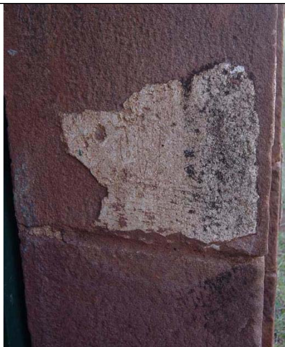
Figura 3: Fragmento de reboco utilizando tabatinga e fragmento de caracóis. Fonte: Stello, 2005 pag. 40.
