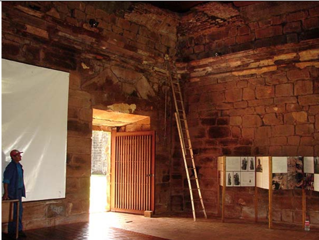
Figura 15. Conjunto II - Sala da Sacristia (interna) Fonte: Foto do Autor
