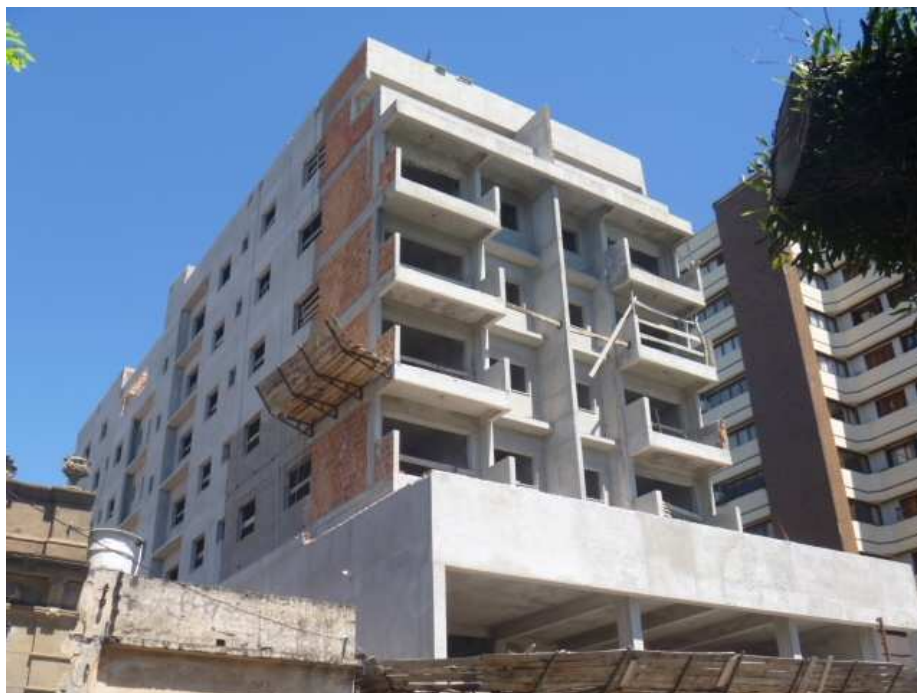
Figura 12 – Fachada do edifício em construção. Fonte: acervo particular.
