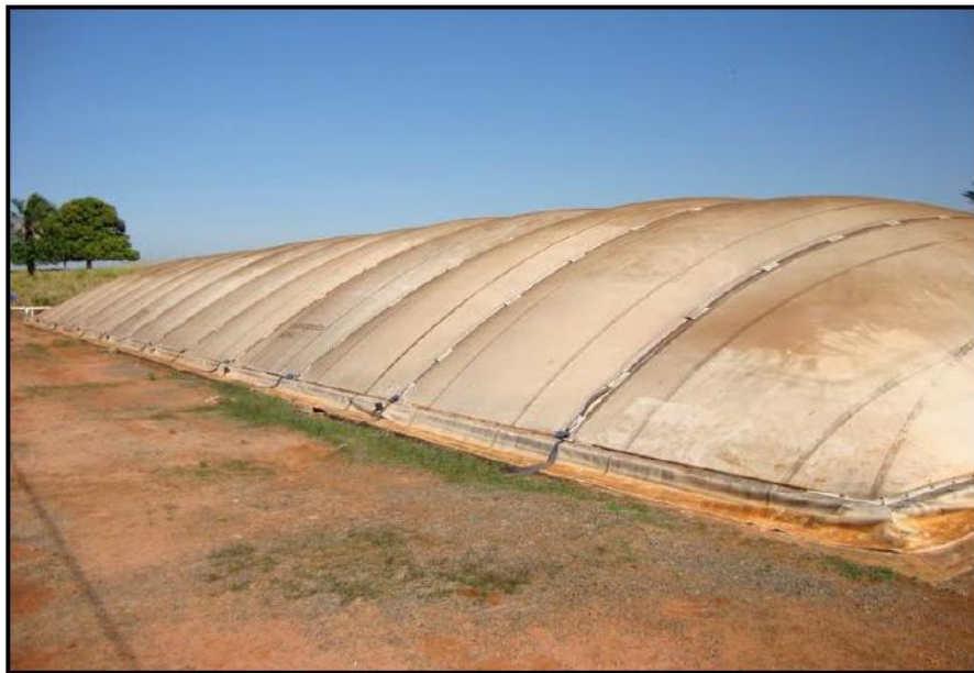
Figura 11 – Biodigestor modelo canadense
