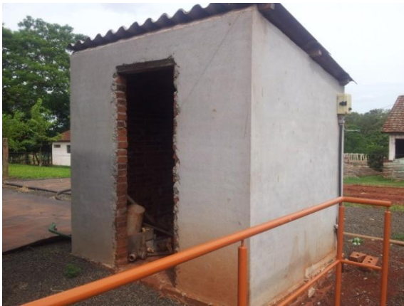
Figura 24 – Vista frontal da casa de comando
