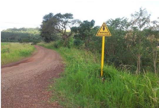
Figura 17 – Gasoduto de biogás
